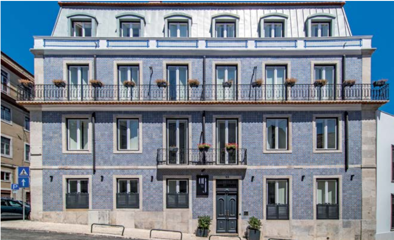
Rehabilitación Edificio de viviendas Calçada do Desterro de Lisboa (Portugal)
