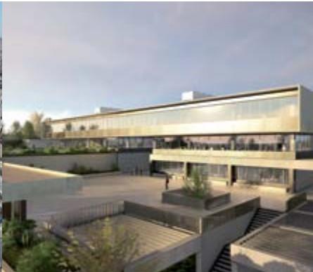
Ciudad de la Tele y nueva Sede del Grupo Secuoya en Tres Cantos, Madrid (España)
