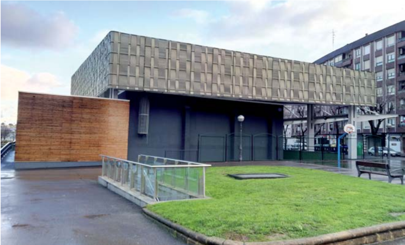
Rehabilitación y cubrimiento del frontón de la Plaza Azoka de Bilbao (España)
