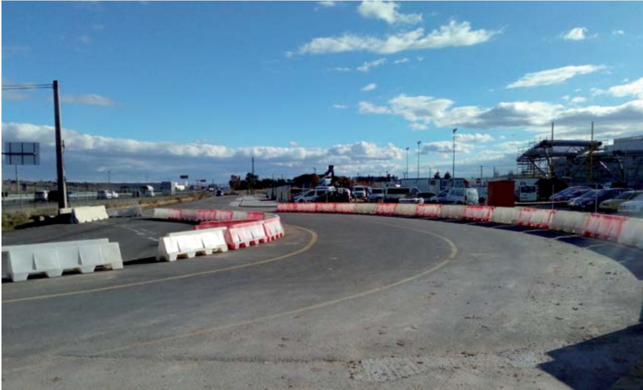
Vía de servicio A-1 de acceso al Campus de Iberdrola en San Agustín de Guadalix, Madrid (España)
