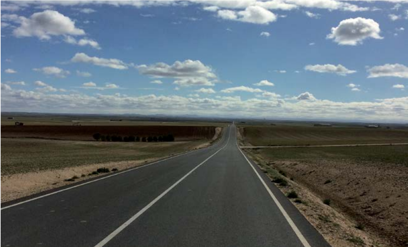
Refuerzo y renovación de firme carretera SA-801 de Peñaranda de Bracamonte a CL-605, Salamanca (España)
