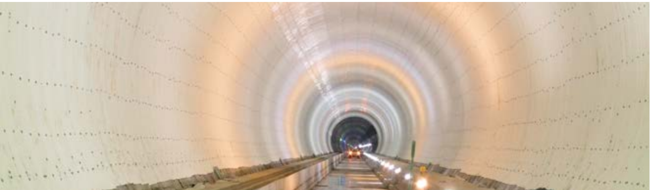
Túneles de Pajares (obras civiles complementarias Lote Sur). AVE Madrid - Asturias (España)
