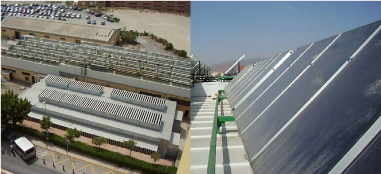
Hospital de Torrecárdenas, Almería (España)
