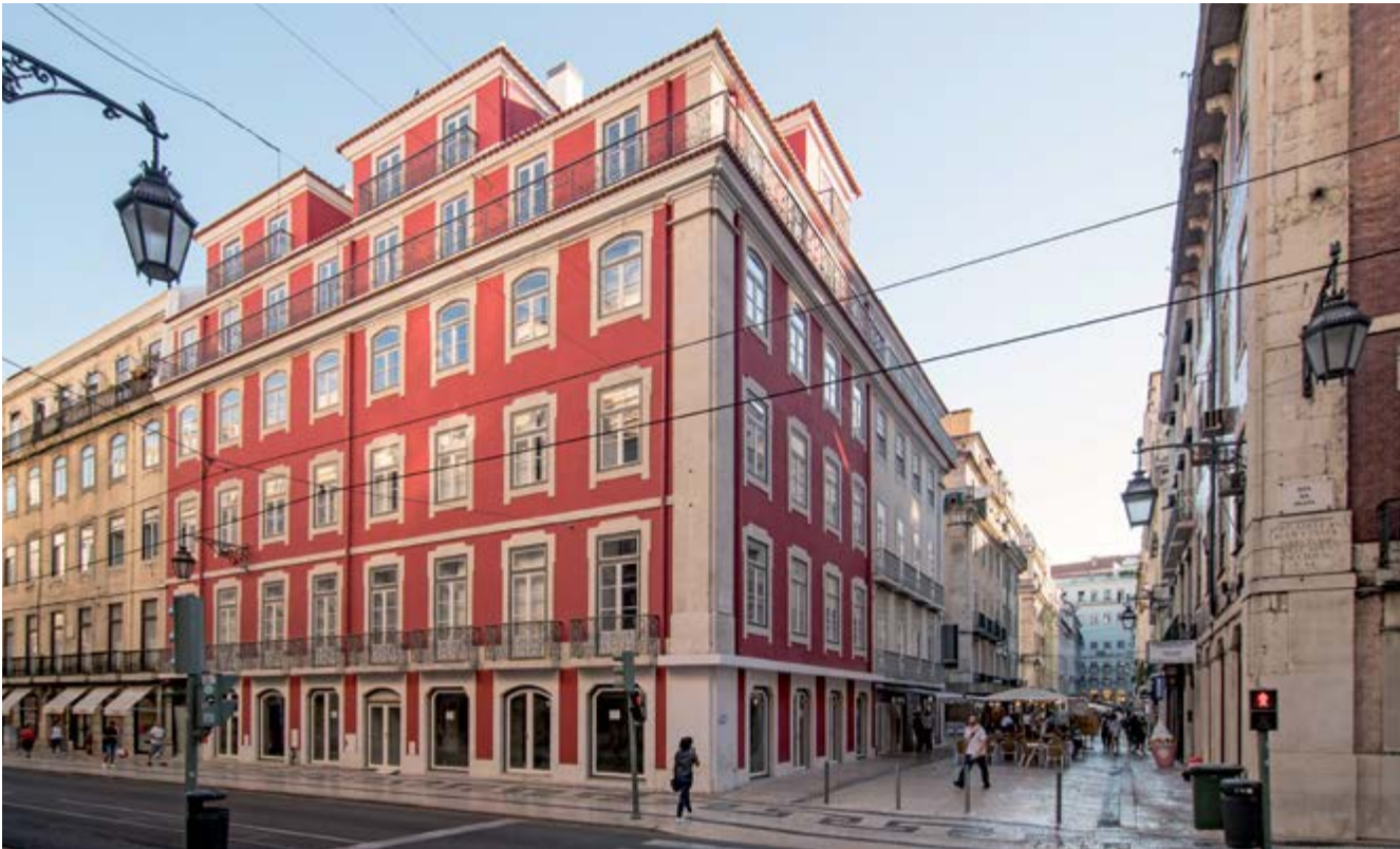
Rehabilitación Apartahotel de 4 estrellas en la calle da Prata, Lisboa (Portugal)
