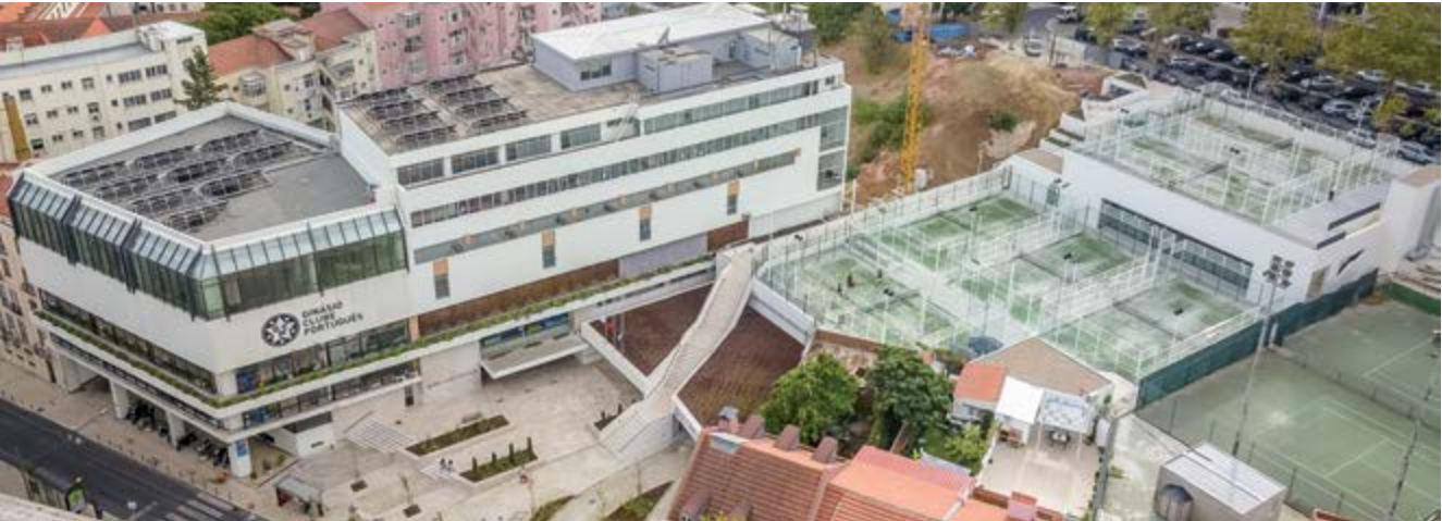
Obras de ampliación y nuevos estacionamientos subterráneos del Gimnasio Clube Português de Lisboa (Portugal)
