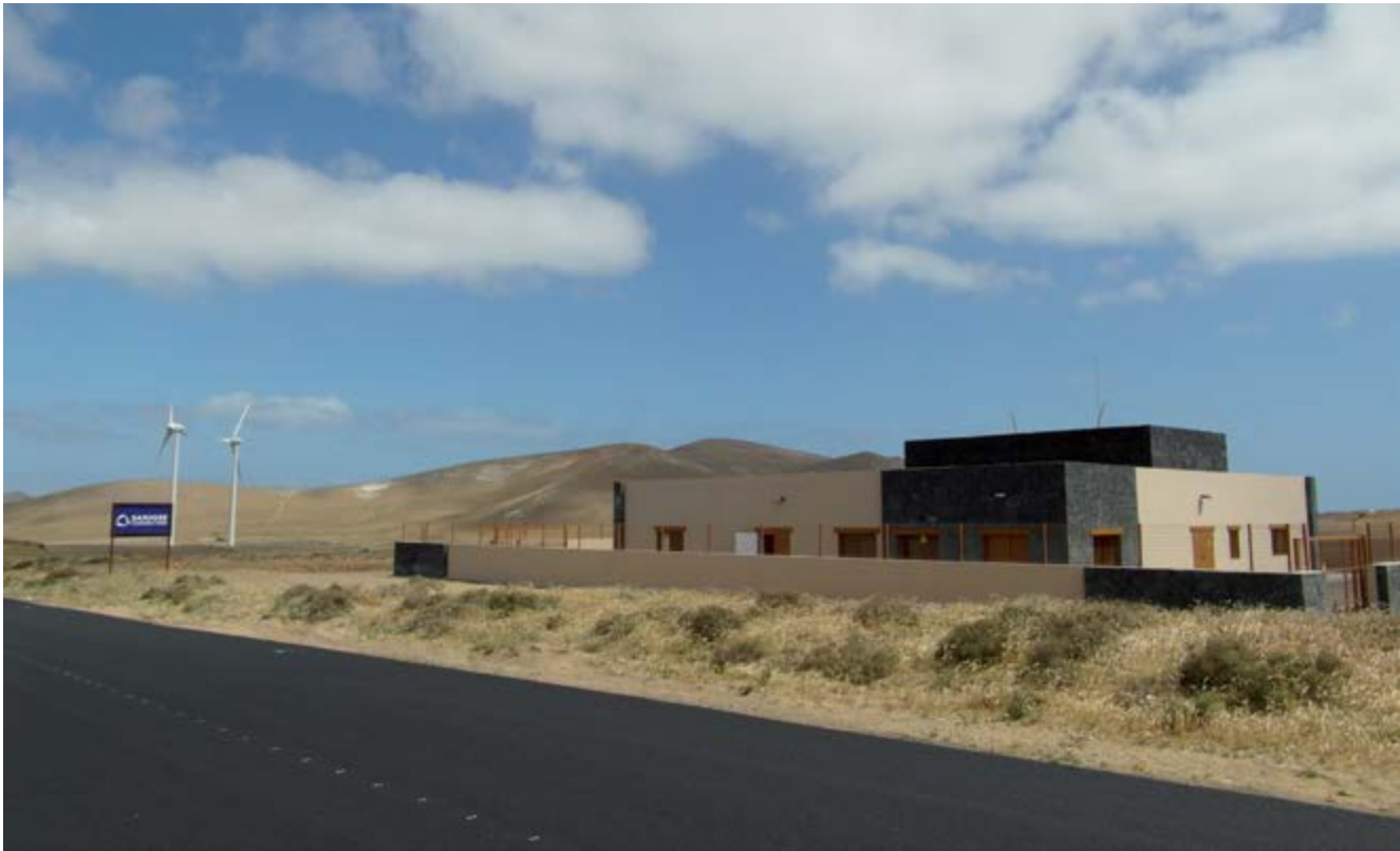
Subestación y Línea de Alta Tensión 20/66KV Consorcio del Agua Callejones de Lanzarote (España)
