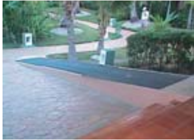
En 2003 el hotel ha instalado siete rampas de accesibilidad para minusválidos en varias zonas del establecimiento ( Meliá Caribe Tropical ).
