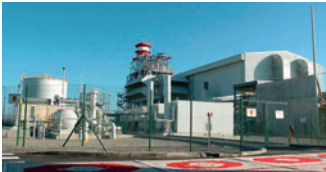
Vista de la central de ciclo combinado de Tahaddart.
