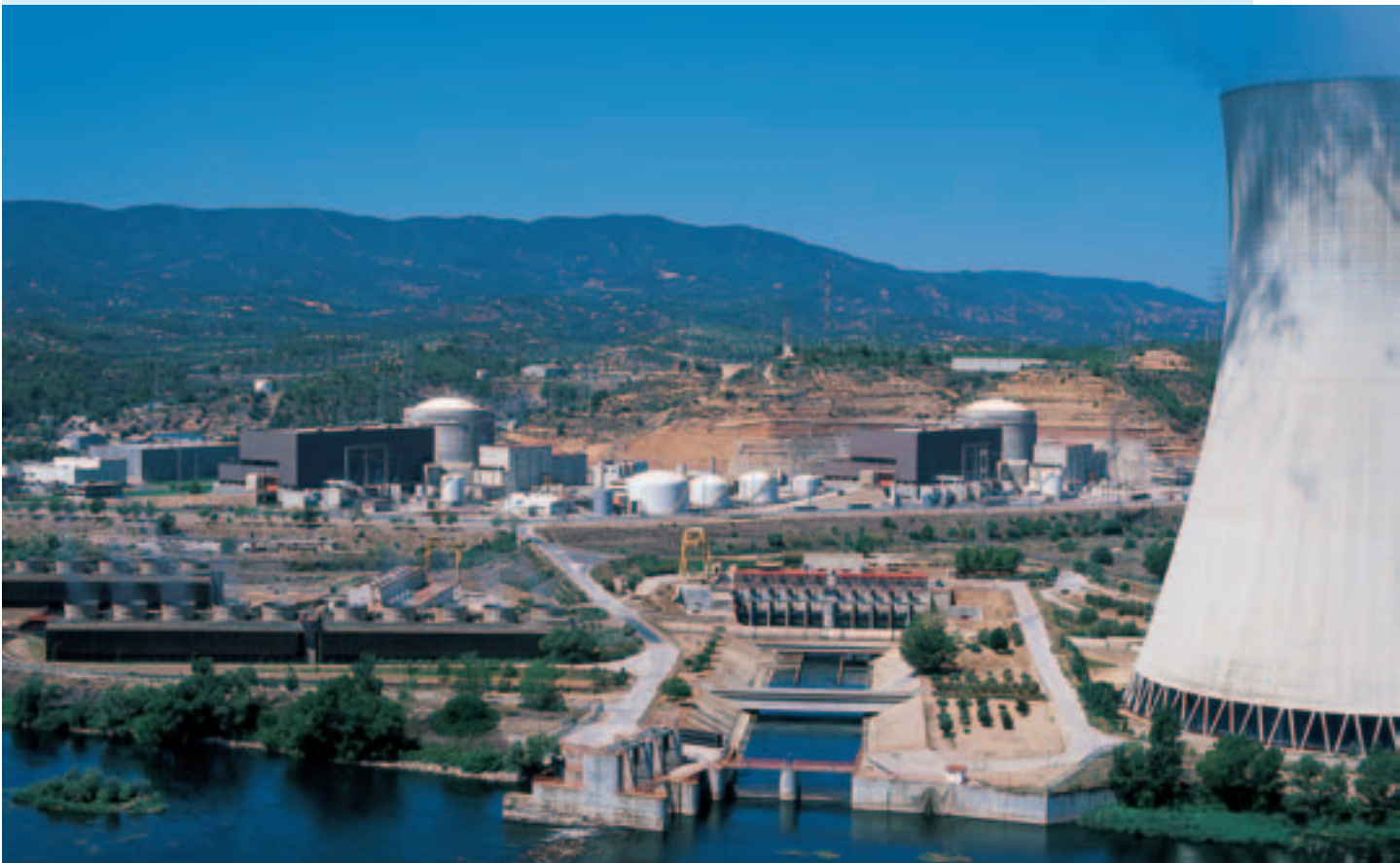
Vista panorámica de la central de Ascó.
