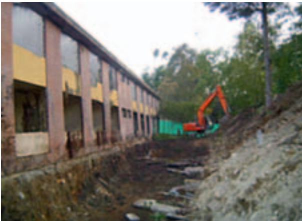
Demolición de los antiguos campamentos de la Central Guavio.
