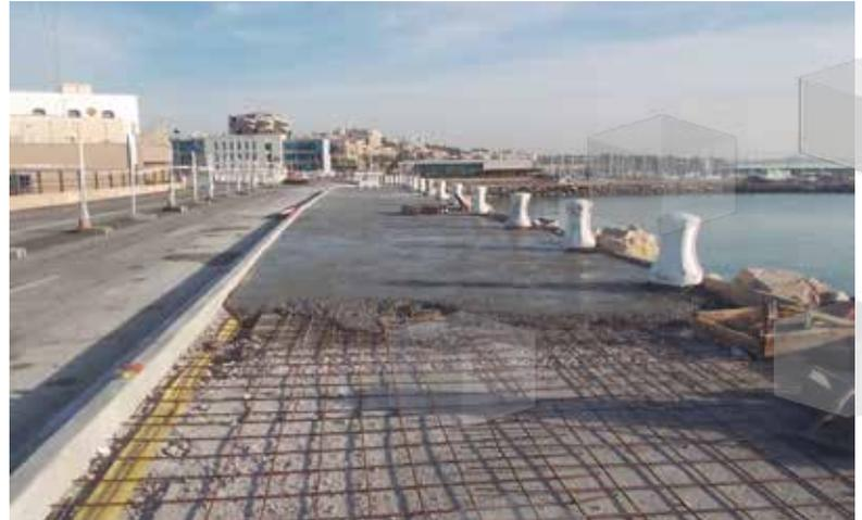
Mejora del firme existente en el vial de circulación del dique de Levant con la ejecución de una nueva capa de rodadura. Delimitación de carriles y mejora del mobiliario urbano existente. Ejecución de una nueva acera.
