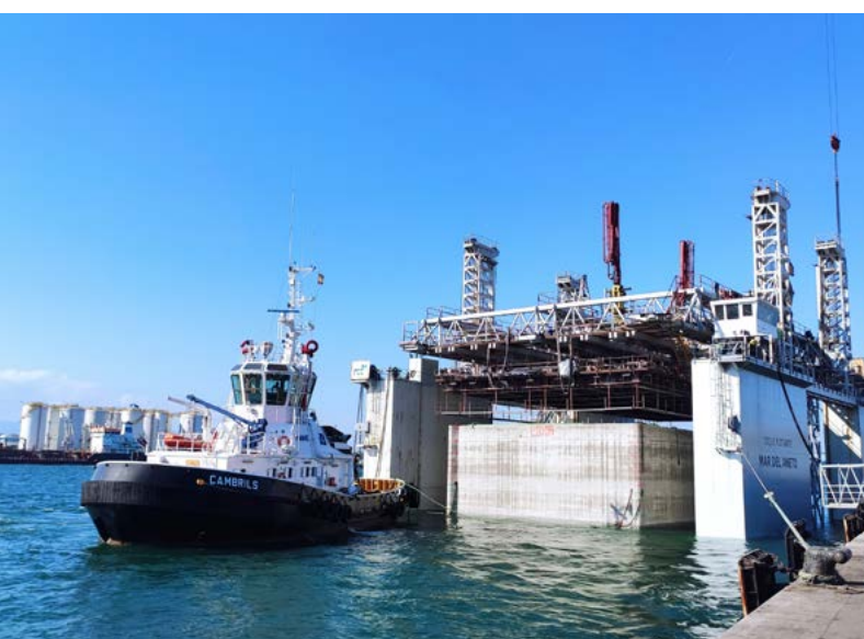
Botadura de cajón en construcción muelle de Balears
