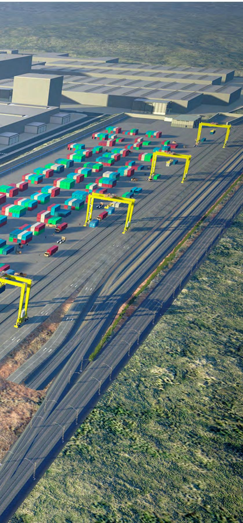
Con la puesta en servicio de la Terminal Ferroviaria Intermodal del Puerto de Tarragona (playa de cuatro vías de 800 m de longitud y con los dos anchos UIC e ibérico en todas las vías), electrificada hasta cabecera, el puerto de Tarragona ya vió en su momento la necesidad de posicionarse en la zona centro de la península, a través de una terminal ferroviaria homóloga en la zona Guadalajara.
