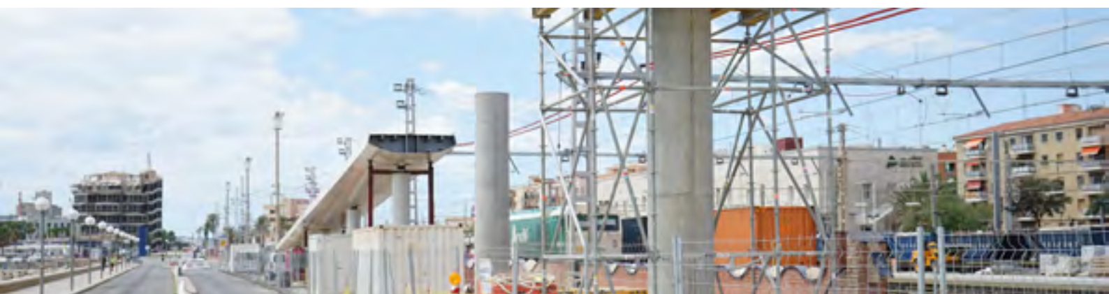
Inici de les obres de la passarel·la Port ciutat
