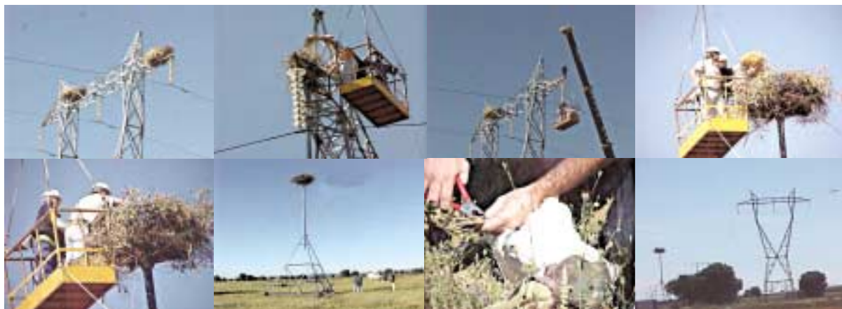
Traslado de unos nidos de cigüeña de una torre de alta tensión a un pedestal artificial
