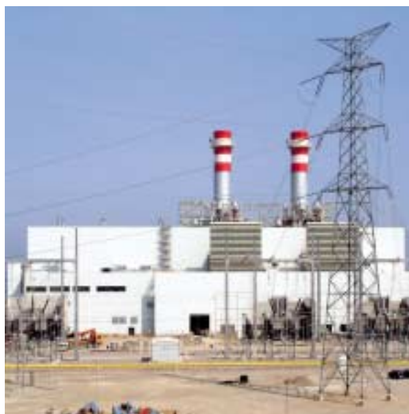
Central de ciclo combinado de Castellón
