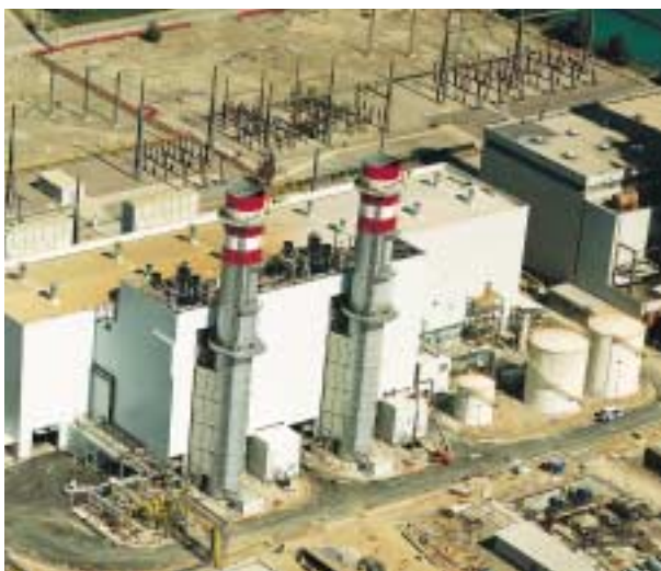
Central de ciclo combinado de Castellón
