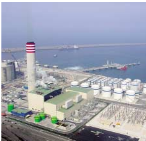
Central de ciclo combinado de Bahía de Bizkaia Electricidad
