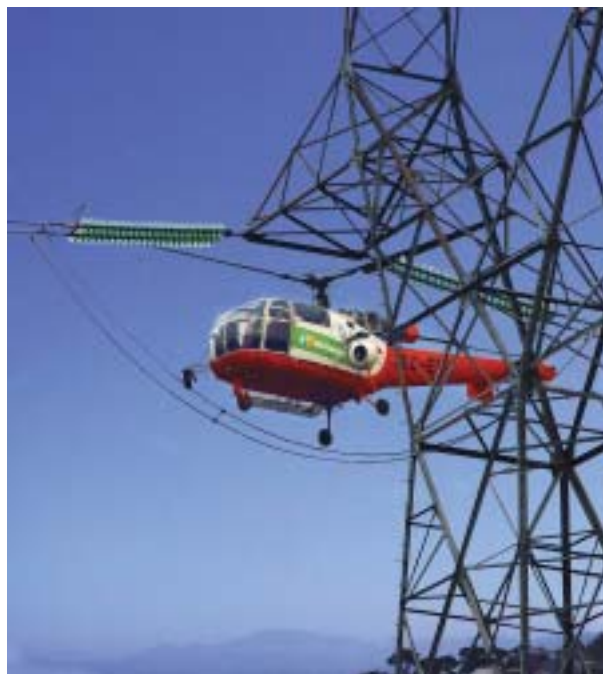
Revisión periódica de líneas de distribución y transporte de electricidad
