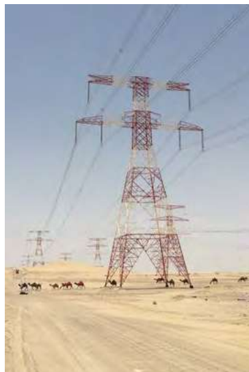
Abengoa ha llevado a cabo la construcción de la línea eléctrica Faya-Shamkha.
