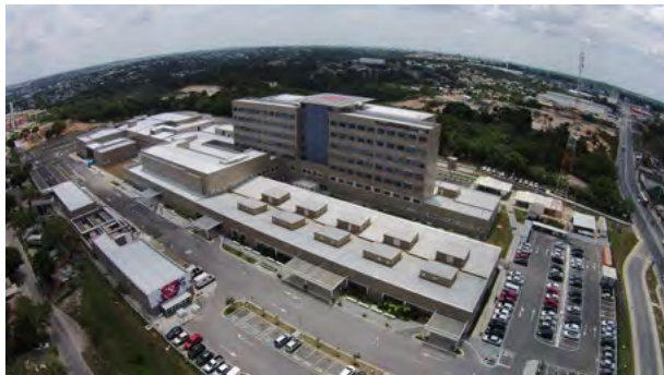
Abengoa se encarga de la operación y mantenimiento del Hospital Zona Norte de Manaus.
