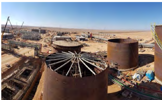
Imagen de los trabajos de Waad Al Shamal.
