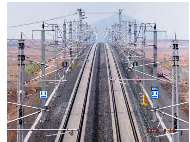
Abengoa participa en la construcción de la línea de alta velocidad que unirá las ciudades de Meca y Medina.
