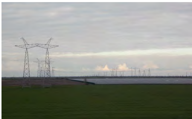
Abengoa continúa con la construcción de una línea a 765 kV de 187 km en Ucrania.
