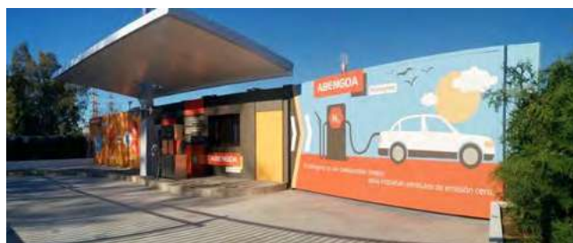
Estación de servicio de hidrógeno.
