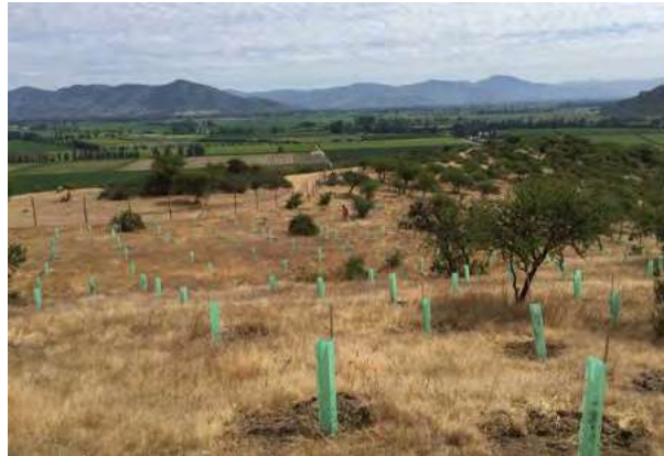
Reforestación asociada al entorno de la subestación eléctrica Puente Negro, de 220 kV.
