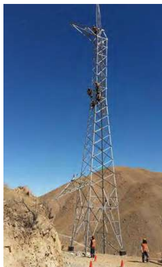
Abengoa se ha adjudicado en 2017 la reubicación de la línea de transmisión 138 kV.
