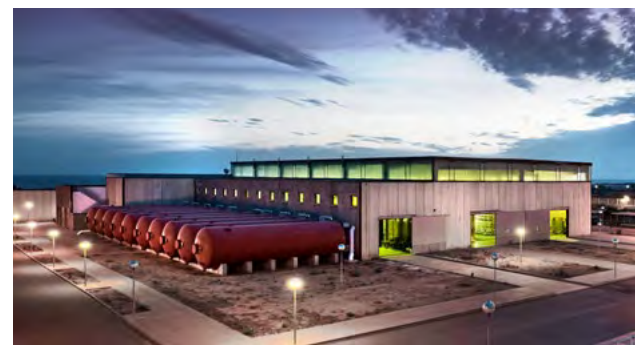
Imagen de la planta desaladora operada por Abengoa en Almería.
