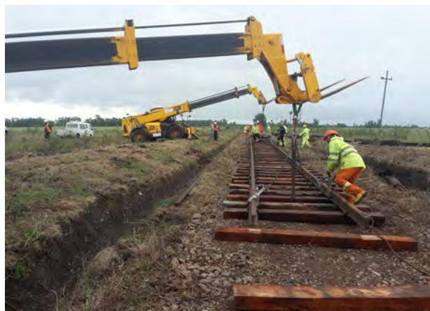
Trabajos de rehabilitación de vías Férreas de Abengoa en Uruguay.
