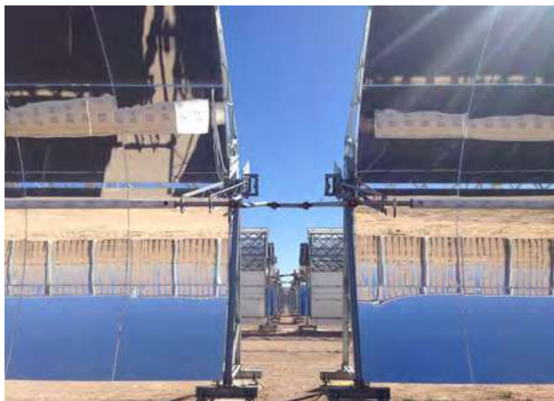
Colectores cilindroparabólicos de la planta híbrida solar-gas Agua Prieta II, de la que Abengoa ha sido responsable de los 14 MW solares.
