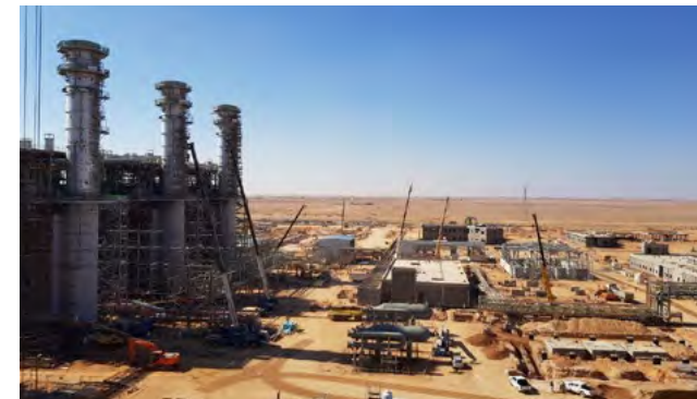
Imagen de los trabajos que Abengoa está desarrollando en Arabia Saudí de la planta Waad Al Shamal.
