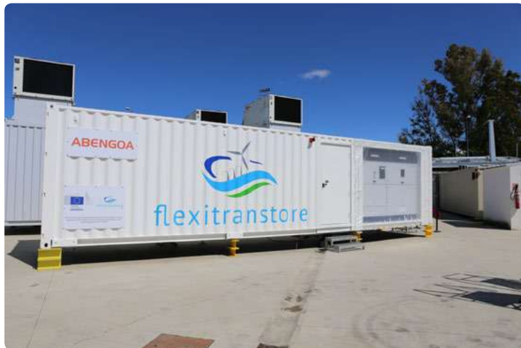
Abengoa es responsable del montaje del demostrador del proyecto Flexitranstore.
