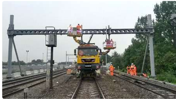
Trabajos de catenaria en Reino Unido.
