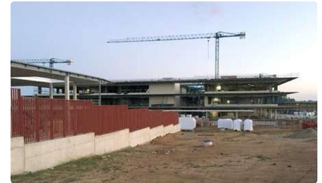
Montajes mecánicos en el nuevo campus de la Universidad Loyola Andalucía.
