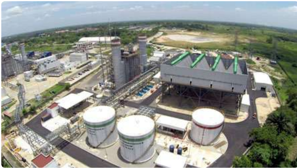
Imagen de los trabajos en la planta de cogeneración eficiente A3T
