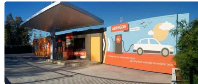
Estación de servicio de hidrógeno.
