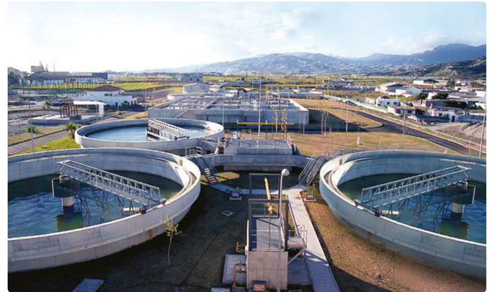
Abengoa construye plantas que reutilizan las aguas residuales de origen urbano.
