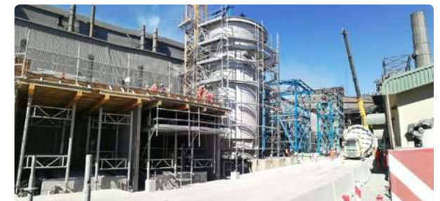
Trabajos en la Fundición de Concentrados de Chuquicamata para Codelco.
