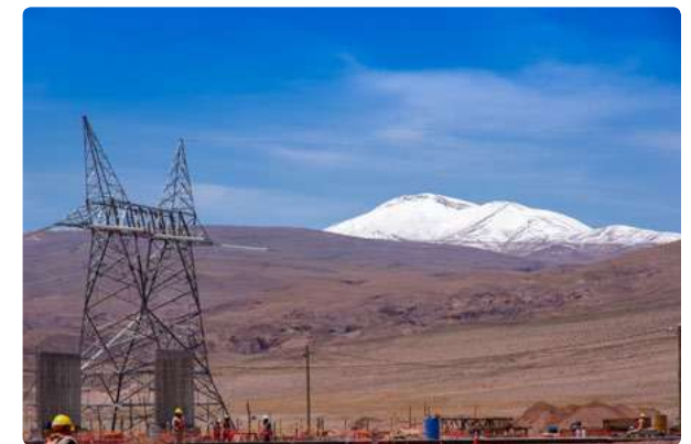
Imágenes de los trabajos en la estación seccionadora Altiplano.
