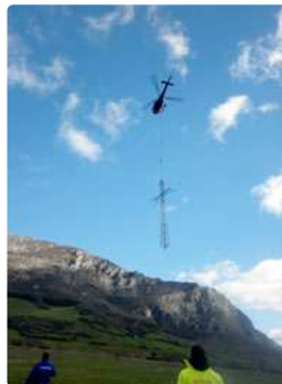
Instalación de torre para despliegue de fibra óptica en Navarra.
