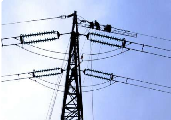
Trabajos en líneas de alta tensión en Francia.
