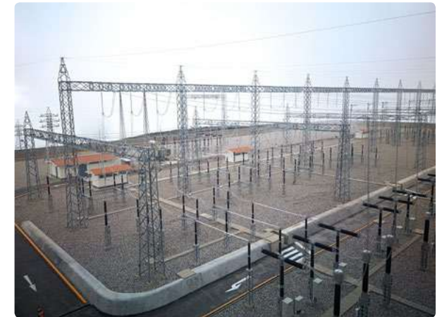
Abengoa está finalizando una subestación de 220 kV en el departamento de Cajamarca.
