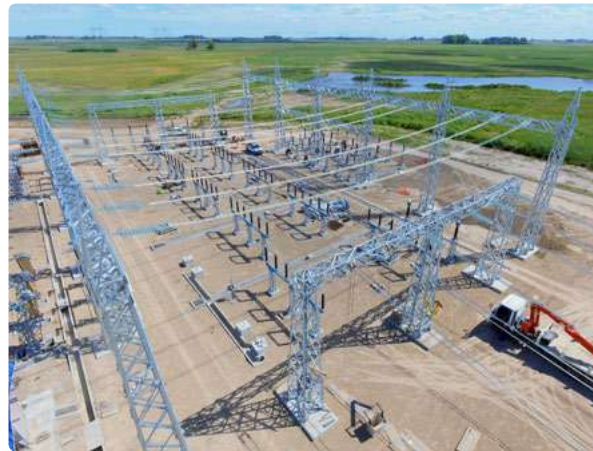
Abengoa ha continuado en 2018 con los trabajos de la estación transformadora 25 de mayo.
