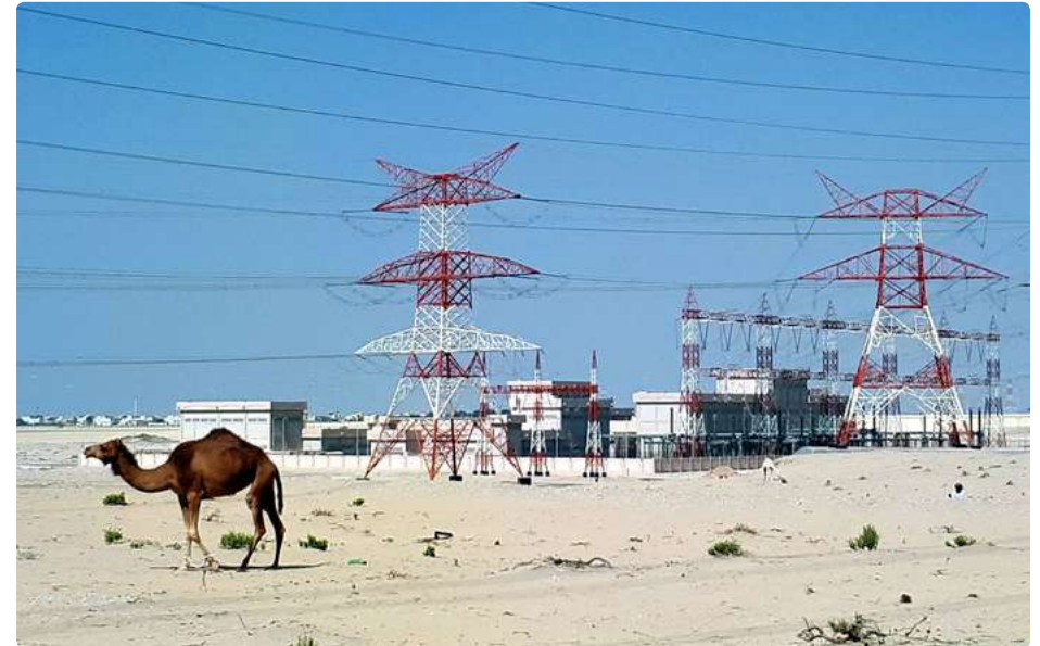
Puesta en operación de la línea de alta tensión Faya-Shamka en Emiratos Árabes Unidos.
