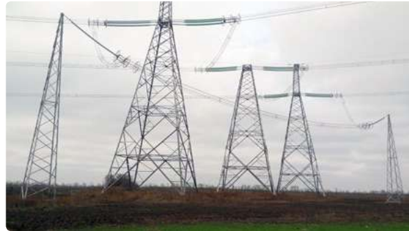
Construcción de una línea a 765 kV en Ucrania de 187 km.
