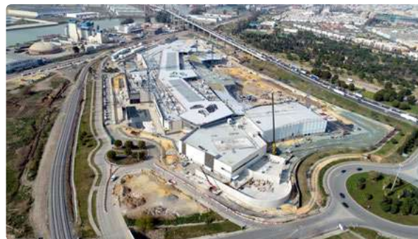
Instalaciones electromecánicas en un centro comercial en Sevilla.
