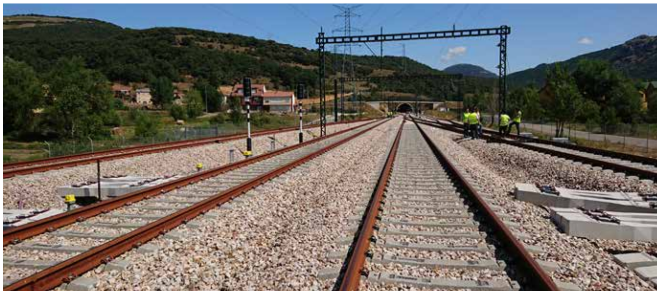
► Túnel de Pajares, donde prosiguen los trabajos de Abengoa en sus sistemas de protección, seguridad y telecomunicaciones.
