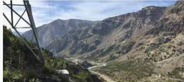
► Línea de transmisión que permite descargar la energía de la planta de generación hídrica Los Cóndores en el sistema interconectado nacional.
