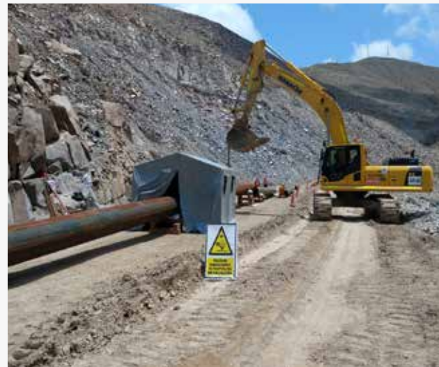
► Trabajos de Abengoa en el proyecto Incapuquio, en Toquepala.
