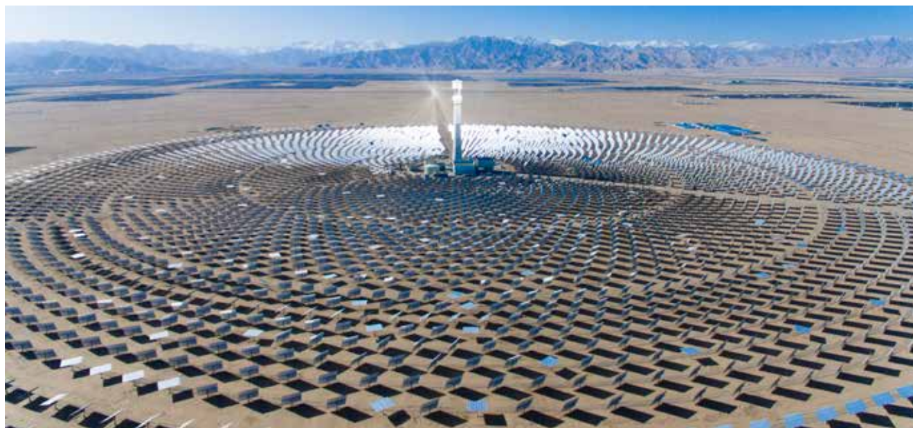
► Planta termosolar de torre Luneng Haixi.
