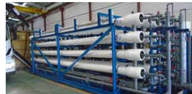
► Abengoa continúa construyendo en México una planta de tratamiento de aguas de proceso y una de aguas residuales para la central de ciclo combinado de Norte III.
