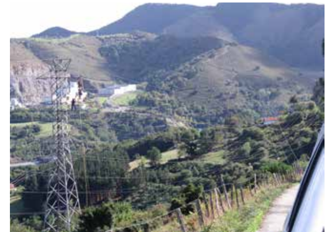
► Línea de transmisión que conecta Alonsotegi con Ortuella, en Vizcaya.
