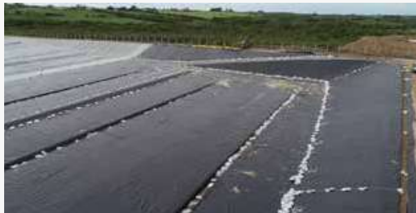
► Proceso de construcción del relleno sanitario en Río Negro.
