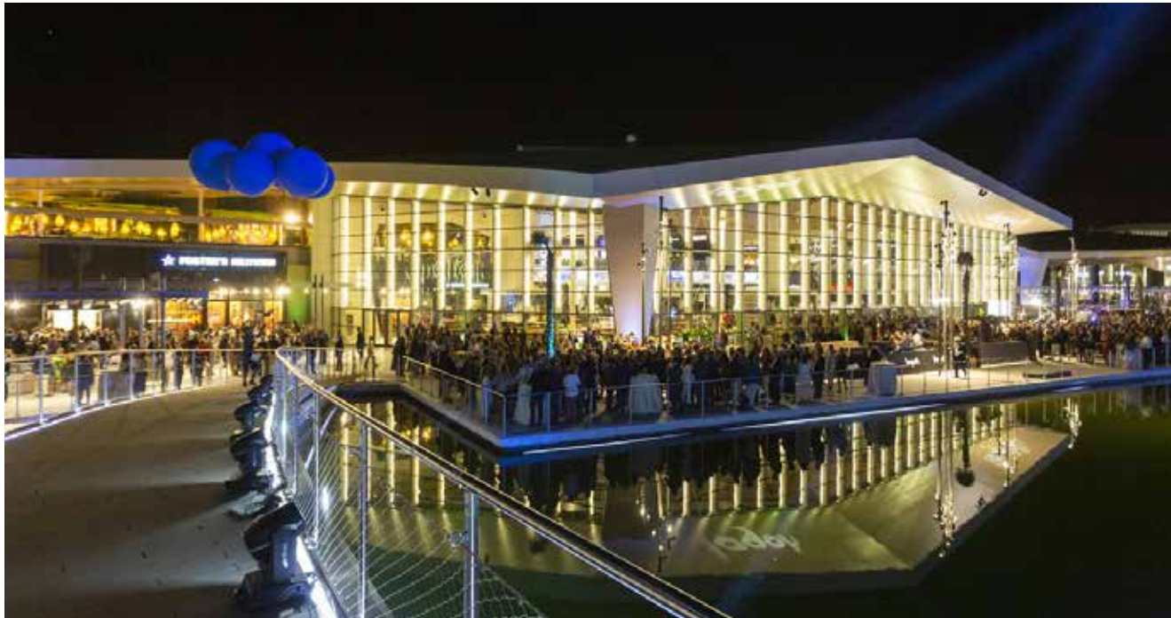
► Abengoa se ha encargado de todas las instalaciones electromecánicas del centro comercial Lagoh en Sevilla.
