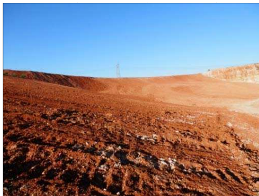
Restauración del talud final
