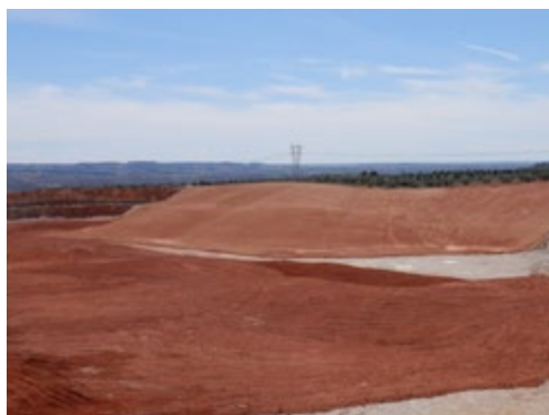
Restauración del talud final
