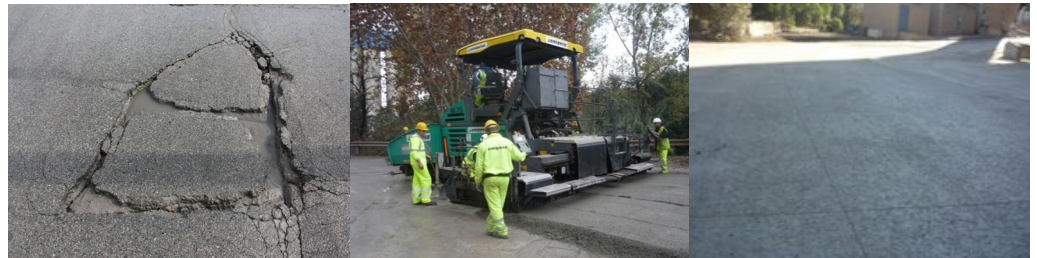
Detalle estado inicial del pavimento de la zona de pruebas, extendido de hormigón con maquina extendidora asfáltica y estado final del pavimento mediante su rehabilitación con whitetopping.
