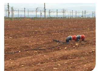
Montaje de sistema de riego
