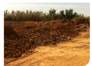
Extendido de Tierra vegetal
