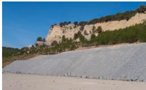
Realización de la morfología en el talud para restauración
