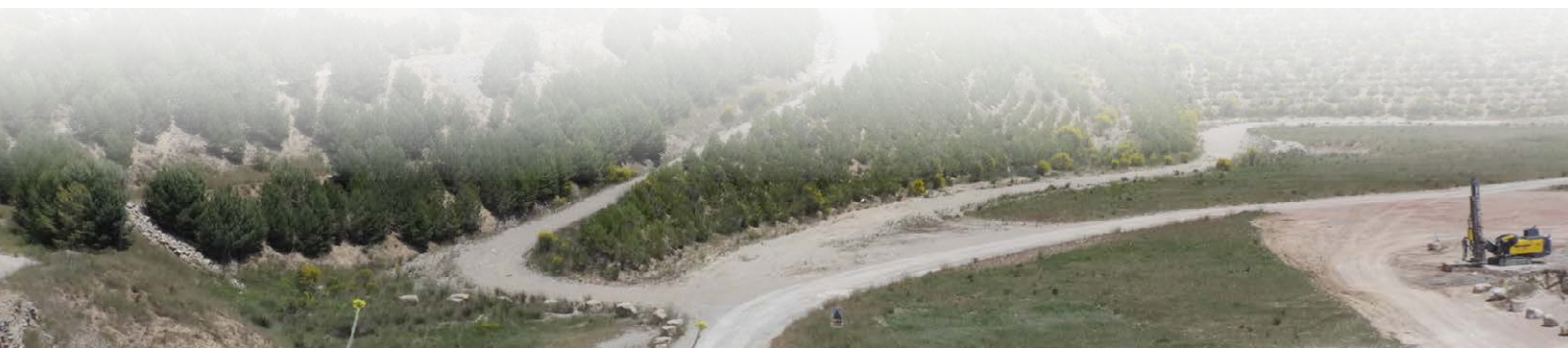
Realización de la morfología en el talud para restauración
