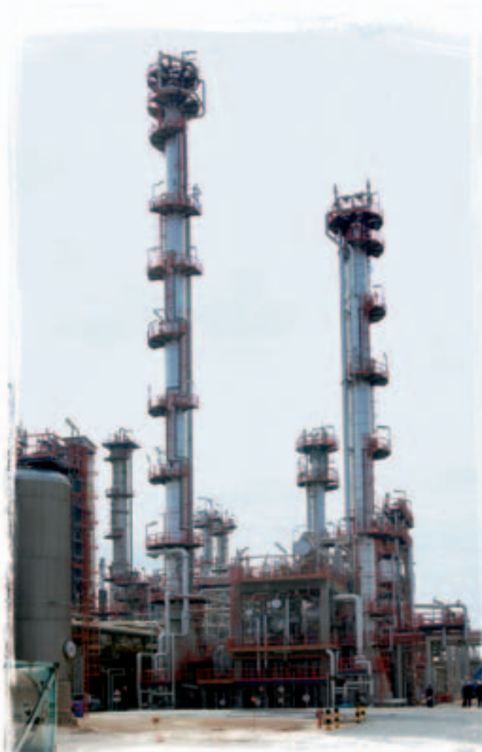
Planta de biocombustibles de la refinería "La Rábida".
