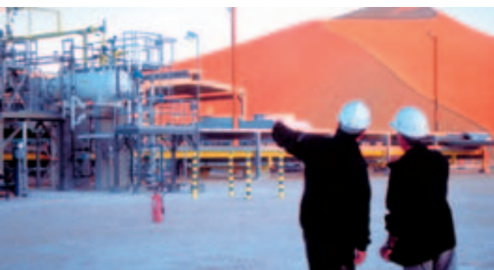
Instalaciones yacimiento Ourhoud en Argelia.
