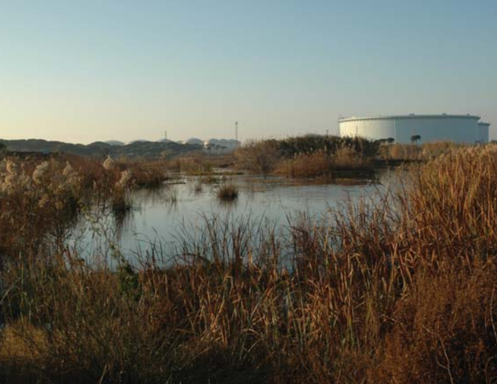
Tanques de almacenamiento de refinería “La Rábida”
