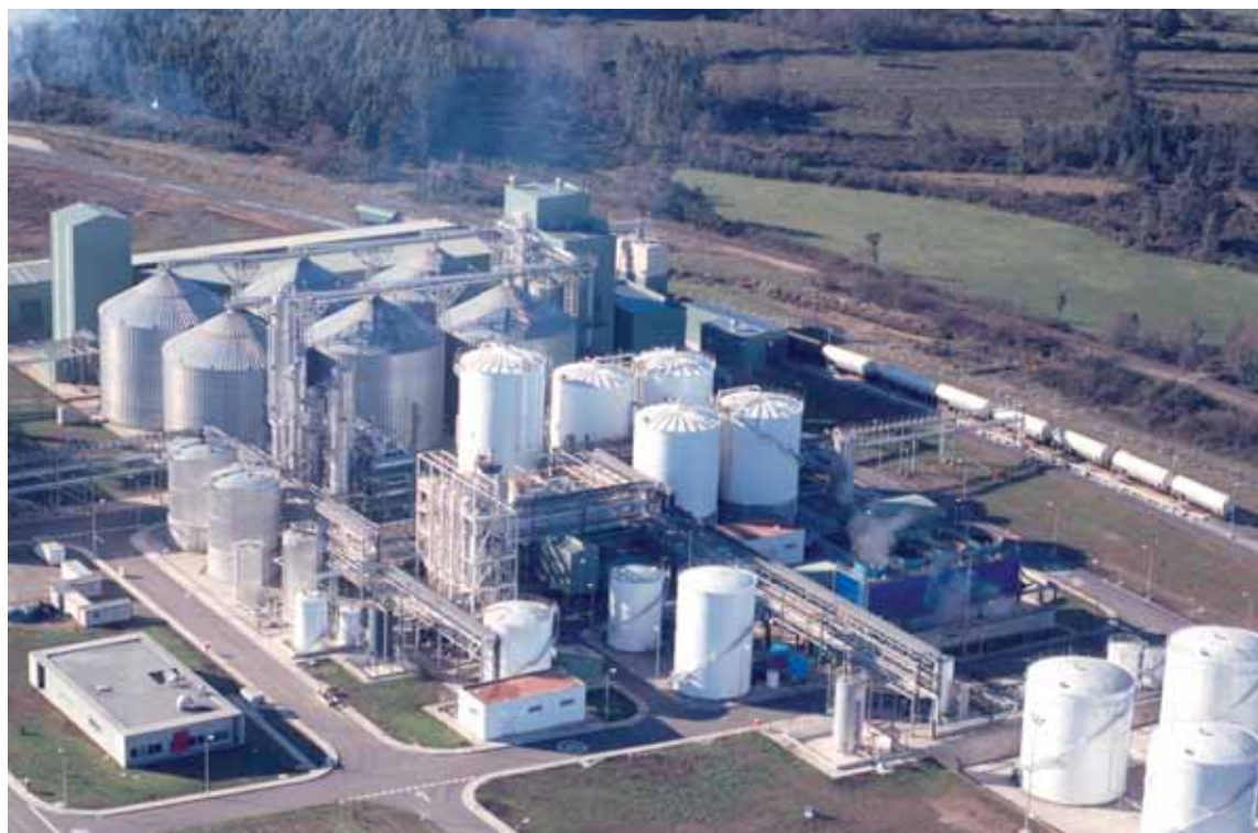
Planta de bioetanol en Curtis. La Coruña
