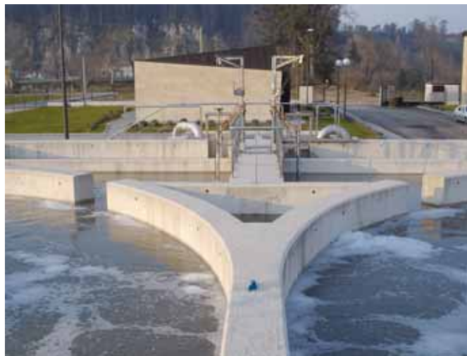
Estación depuradora de agua residual en Cabezón de la Sal. Cantabria
