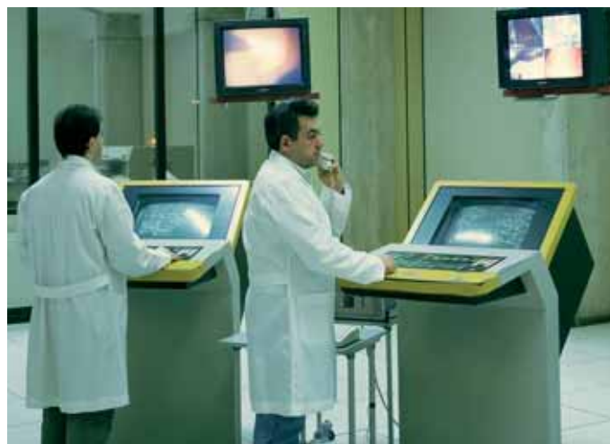
Sala de control de la fábrica de cemento en Olazagutía. Navarra
