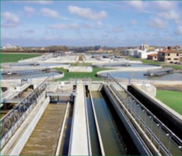
Estación depuradora de aguas residuales. Salamanca
