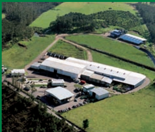
Planta de tratamiento de residuos sólidos urbanos. Barbanza
