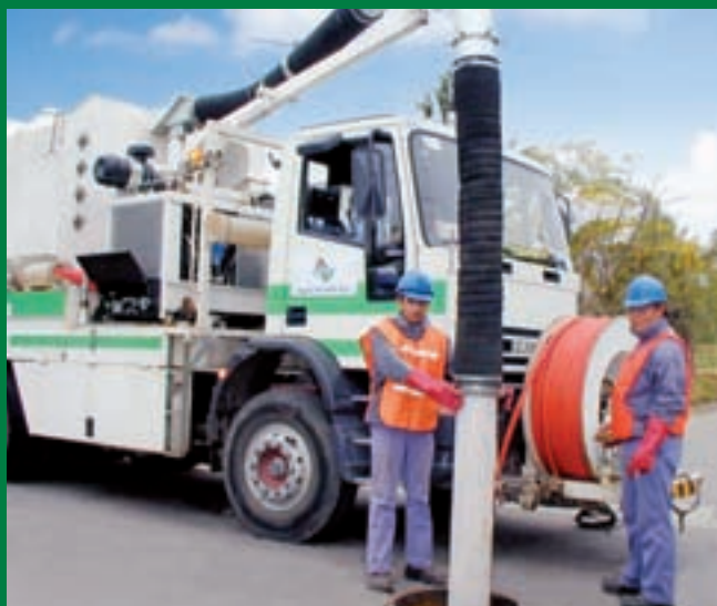
Limpeza de alcantarillado. Aguas del Valle. Argentina
