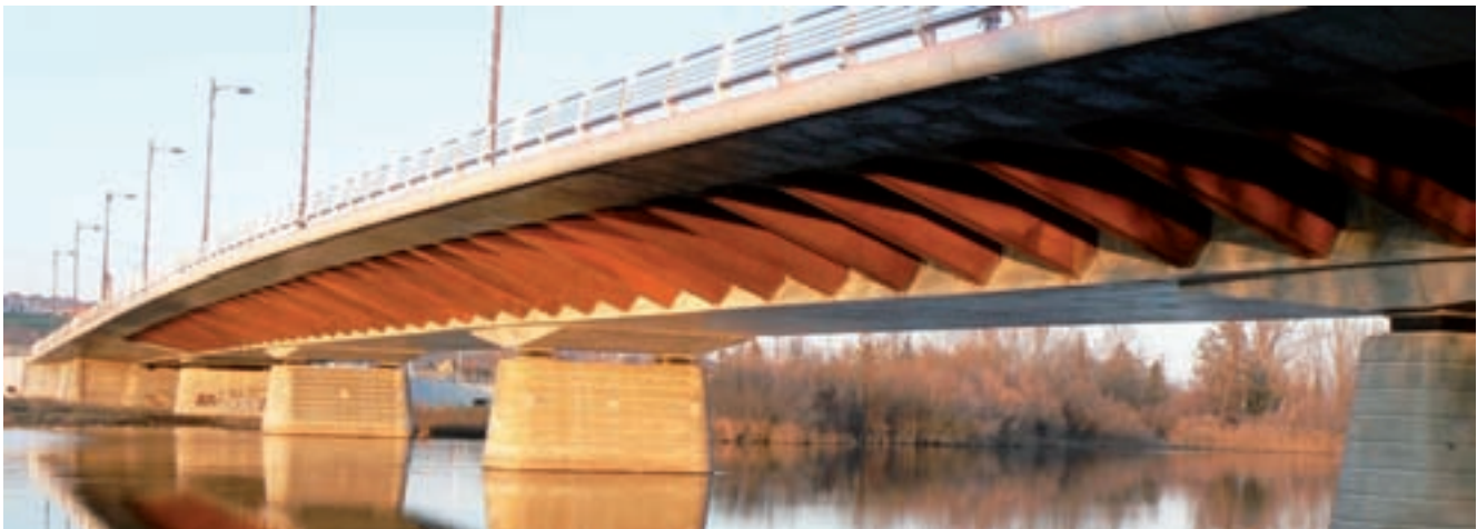
Puente de la Serna. Salamanca
