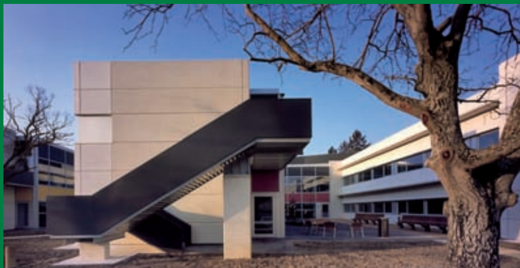
Centro de disminuidos psíquicos. Pamplona. Navarra
