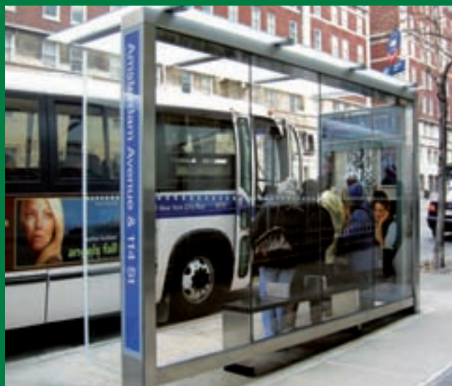
Marquesinas de paradas de autobuses. Amsterdam. Nueva York
