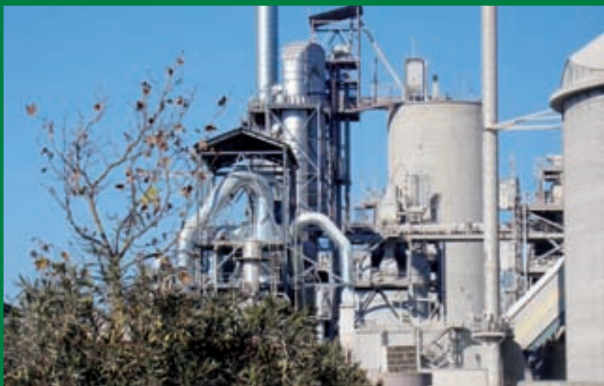
Fábrica de cemento El Alto. Morata de Tajuña. Madrid
