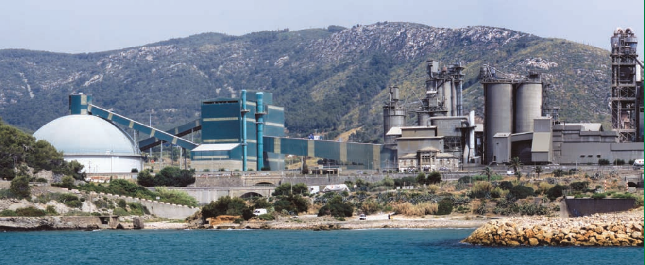
Fábrica de cemento. Vallcarca. Barcelona
