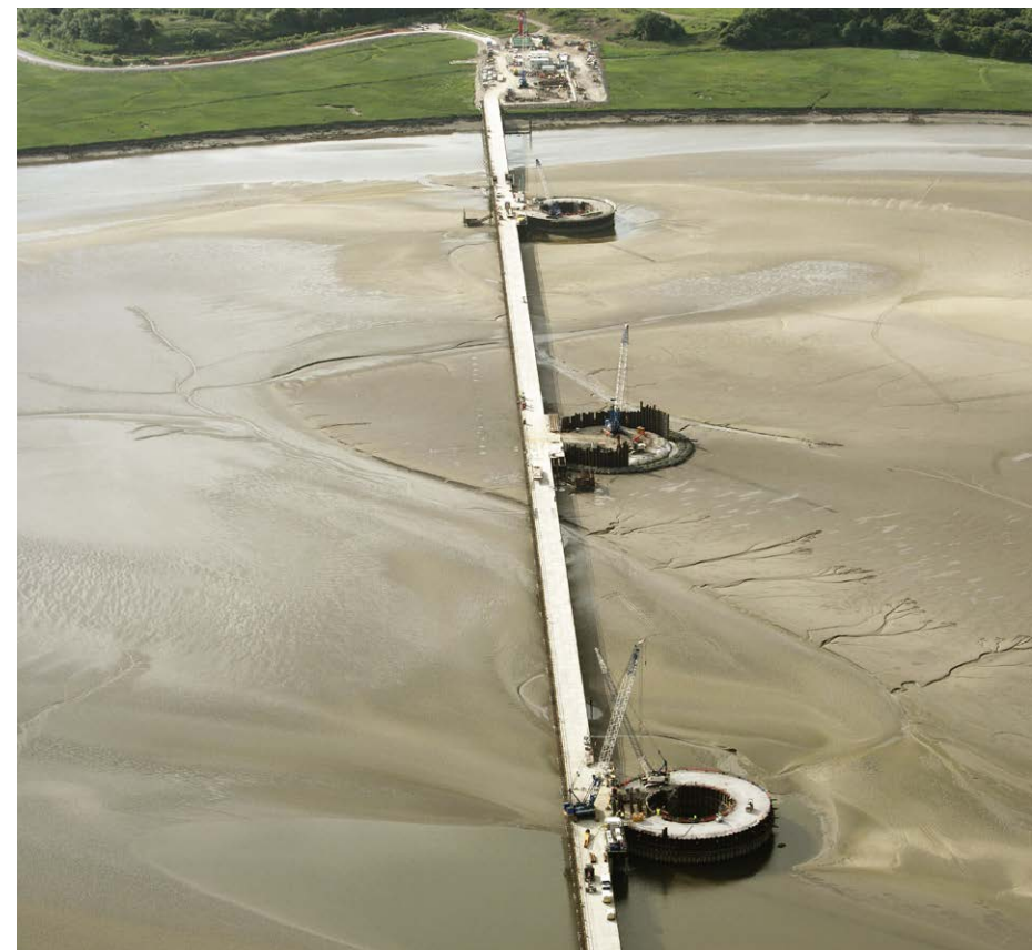
Puente de Mersey (Reino Unido).
