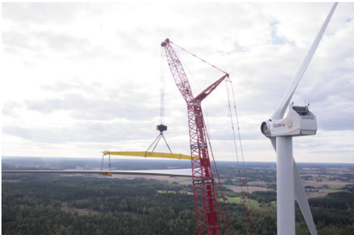
Montaje del primer parque de Gamesa con turbinas de 5 MW (Salo, Finlandia).
