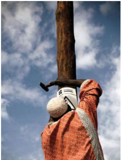
Proyecto de electrificación en Senegal.
