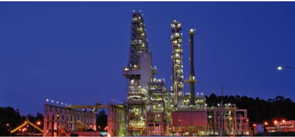
Instalación industrial de Repsol YPF.
