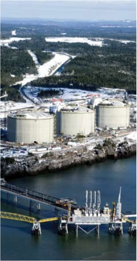
Planta de regasificación Canaport LNG (Canadá).
