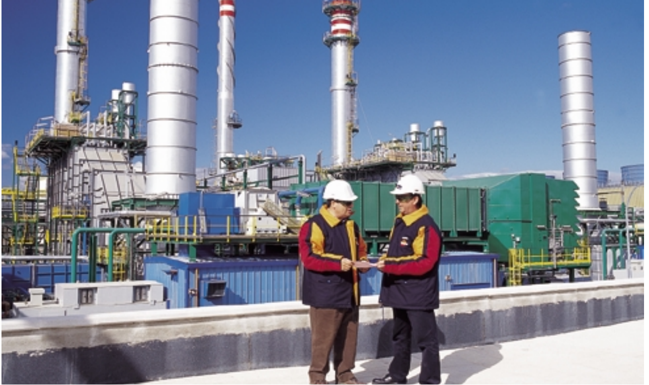
Repsol YPF dispone de una potencia instalada de 296,6 Mw en unidades de cogeneración.
