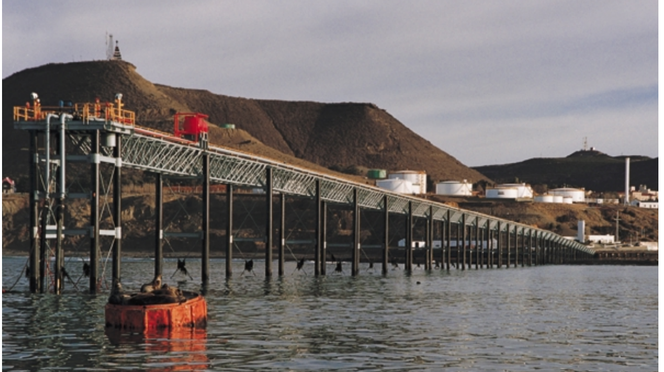
Las modernas instalaciones de carga y descarga en terminales marítimas reducen el riesgo de derrames al agua (Comodoro Rivadavia, Argentina).
