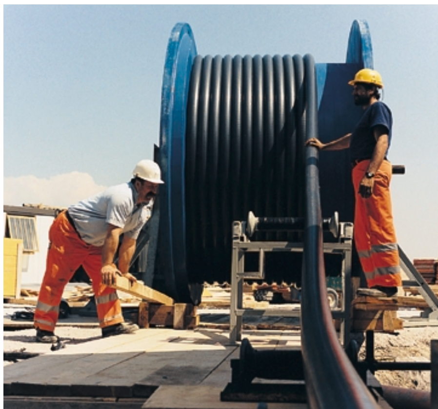
Posa di cavo interrato
