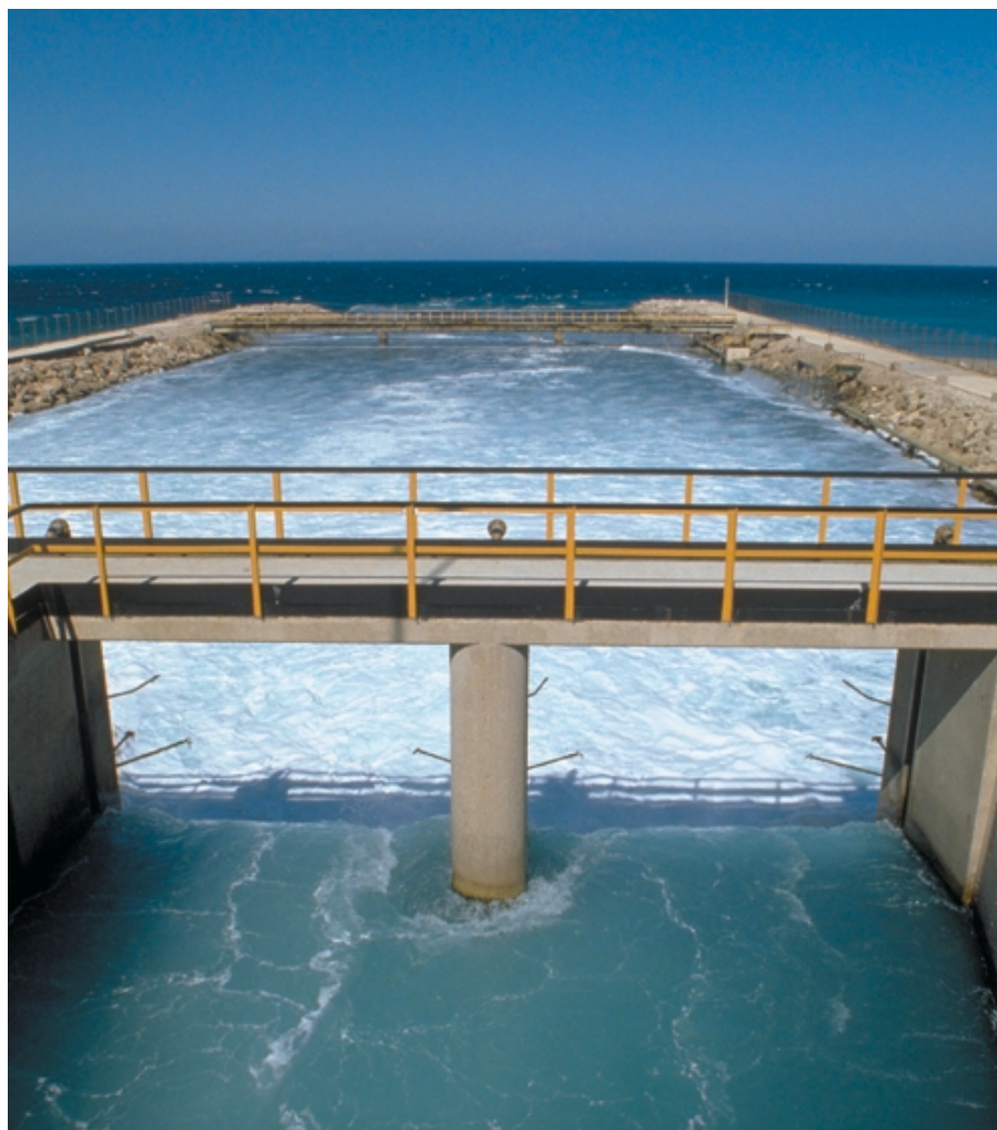
Centrale termoelettrica di Brindisi Sud. Canale di scarico dell'acqua di raffreddamento
