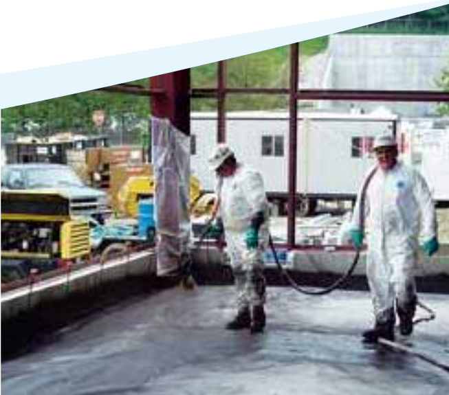
Einbau einer Gasbarriere zur Reduzierung von Expositionsrisiken
