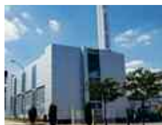
Neue Feuerungsanlage und Aufbereitungsanlage für Luftemissionen im Produktionszentrum Vitry
