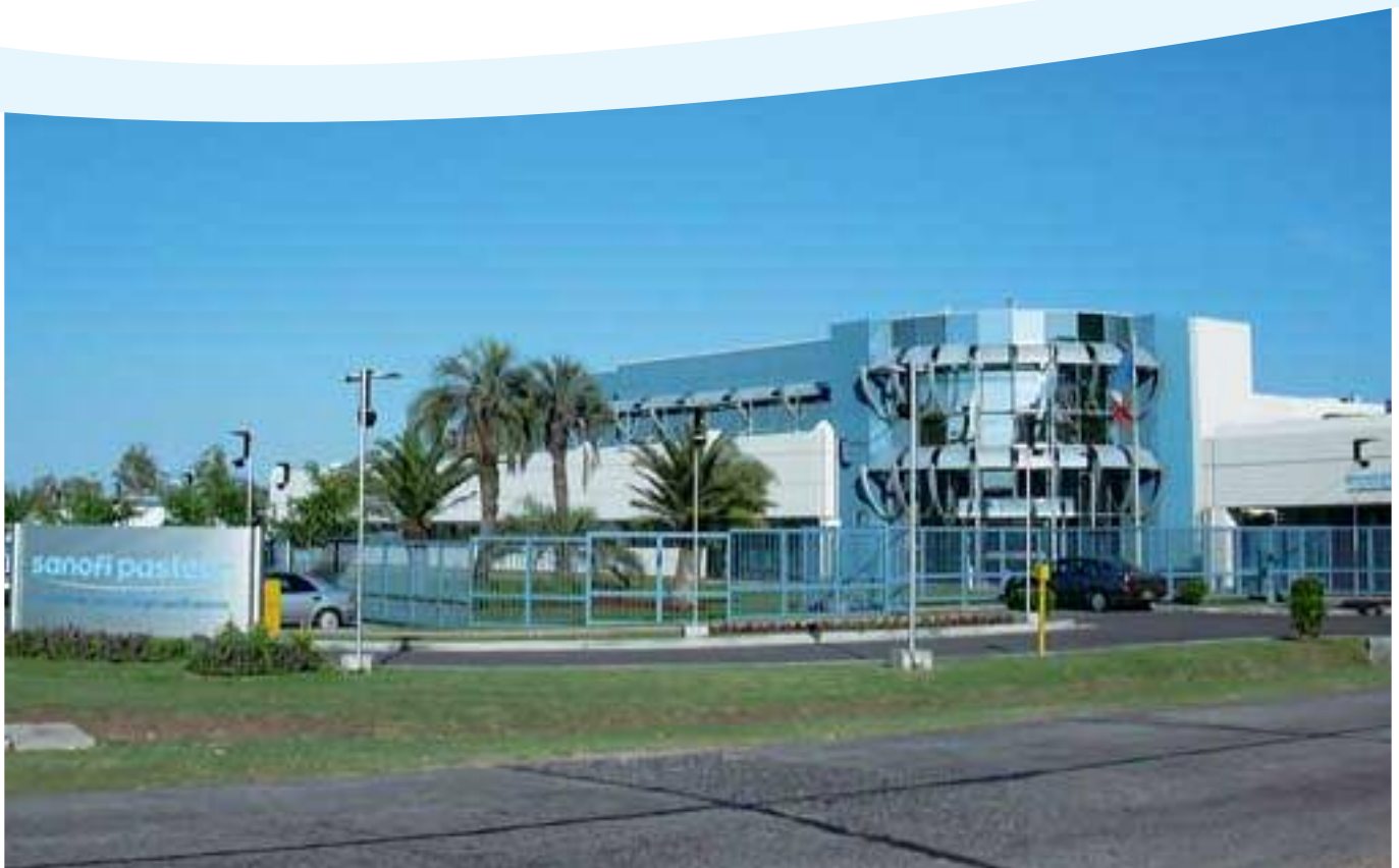
Der Industriestandort Pilar von sanofi pasteur in Argentinien
