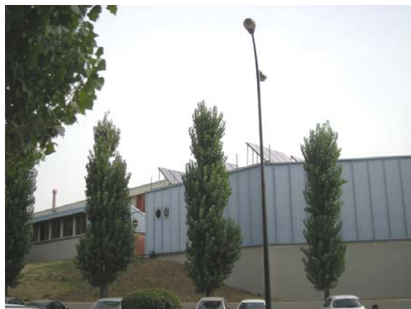
Imatge 14. Col·lectors solars tèrmics al poliesportiu del SAF.
