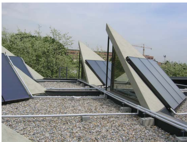
Imatge 13. Col·lectors solars tèrmics a la coberta de la sala fitness del SAF.
