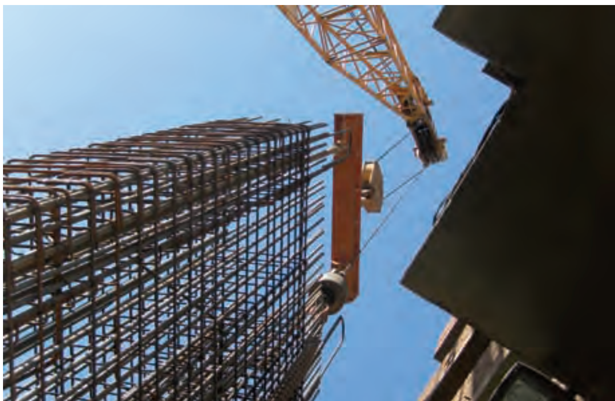
Detalle izado armadura
