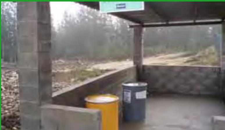
Ubicación de las instalaciones de almacenamiento de combustible fuera de áreas permeables, donde fugas accidentales puedan contaminar las aguas subterráneas. Los tanques de almacenamiento disponen de bandeja y no se sitúan en zonas sensibles. Obra "Estación de Goya UTE".
