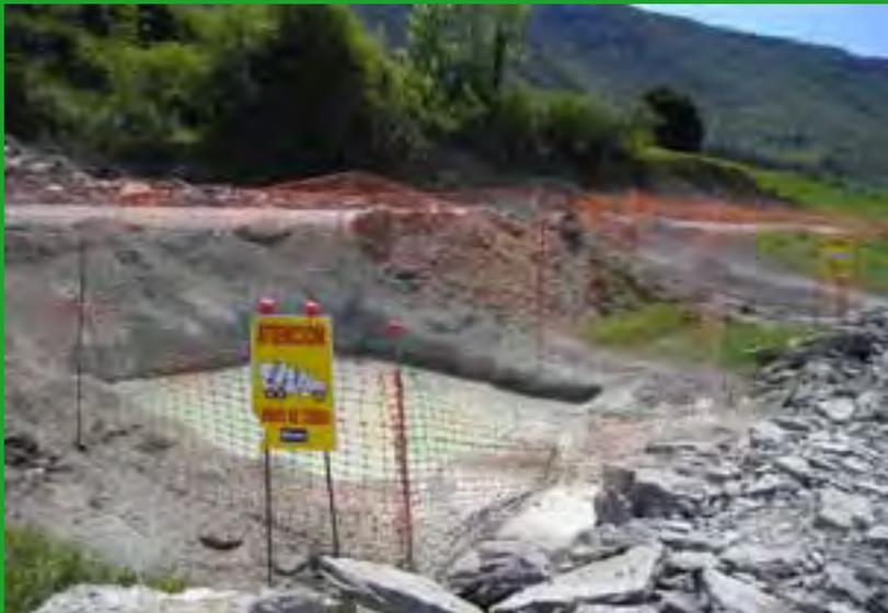
Zona de lavado de canaletas (gunitada para mayor impermeabilización de la misma).
