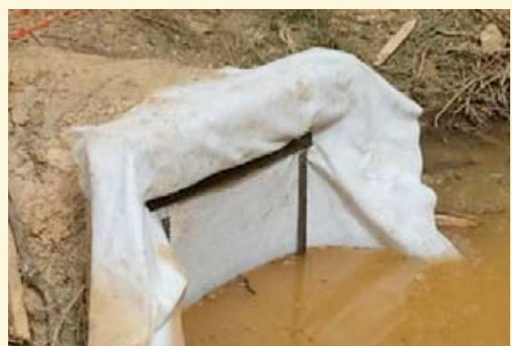
Instalación de geotextil como barrera de retención de sedimentos en las márgenes del río Carrón. Obra UTE Variante de Guardo. Palencia.
