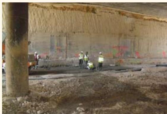
25/05/2011: Hormigón de limpieza de la galería de comunicaciones. Un total de 29 m<sup>2</sup>
