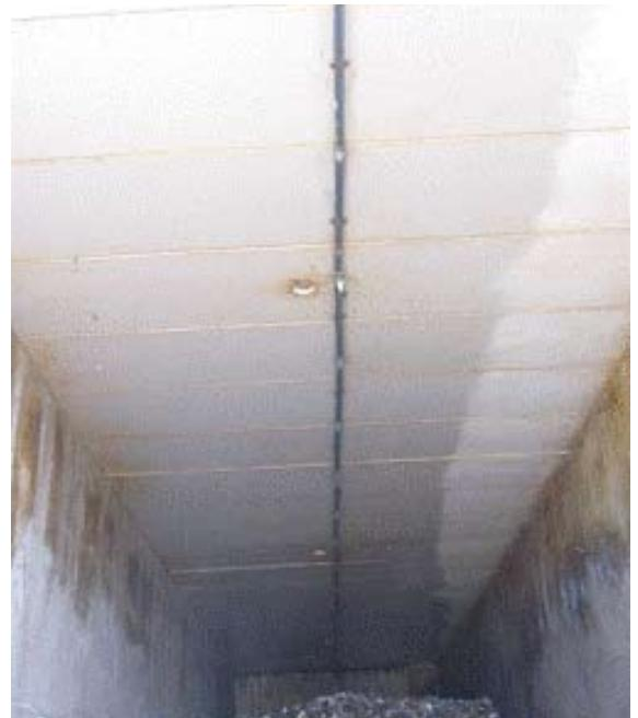
> Circuito de riego de lixiviado en túneles de maduración
