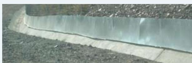
> Detalle de la chapa colocada en el cerramiento para impedir el acceso del camaleón a la Autopista
