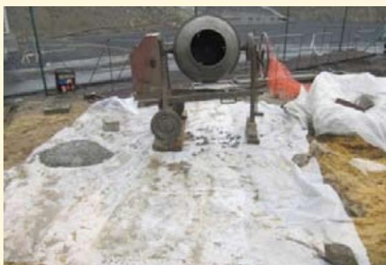
Colocación de telas plásticas bajo hormigoneras para proteger el suelo de eventuales derrames de hormigón y de aguas de lavado. Obra “Proyecto de expansión de la terminal de GNL de Sines”, Portugal.
