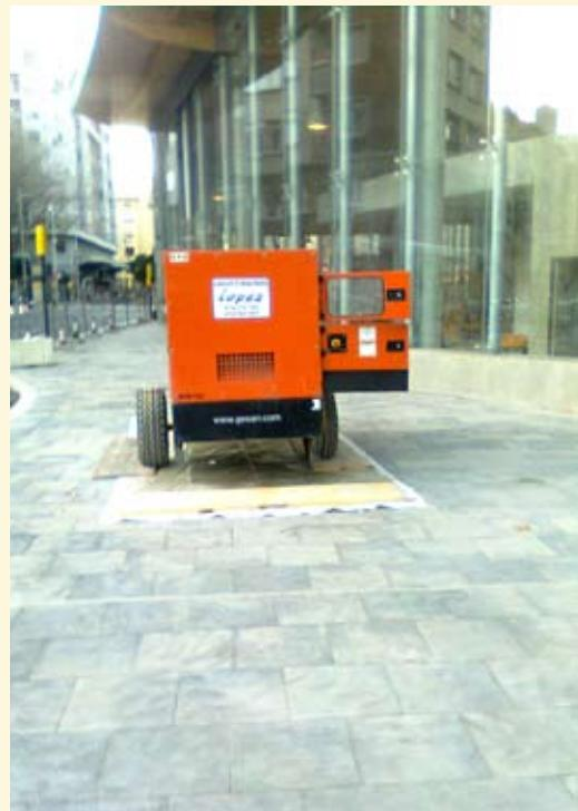
Colocación de geotextil y plástico debajo de los grupos electrógenos para evitar derrames sobre el terreno o pavimento. Obra “UTE Estación de Goya”, Zaragoza.
