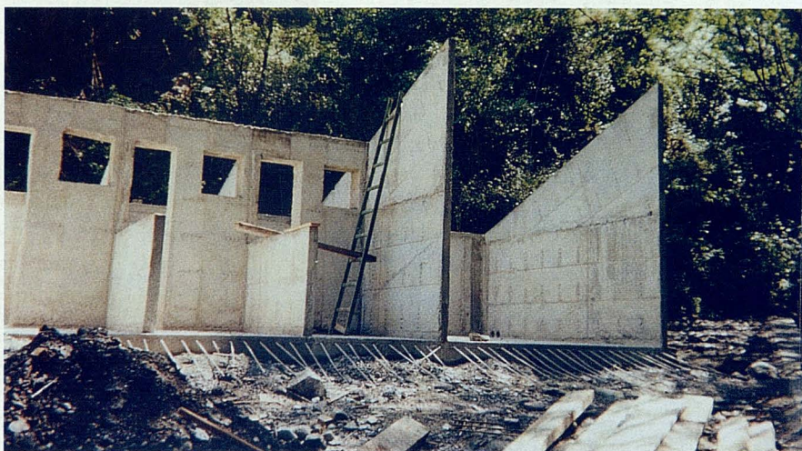
La misma parte que la foto anterior durante su construcción. Todo en hormigón armado. A la derecha el pequeño almacén y los boxes viéndose las separaciones, así como el hueco de la puerta y de la ventana de cada.
