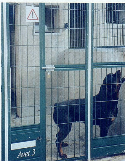
Detalle de los paneles y su identificación. Obsérvese el espacio de 2,5 cm que separan los paneles del suelo, para dejar pasar las aguas sucias hacia la canal. Los excrementos sólidos se recogen aparte.
