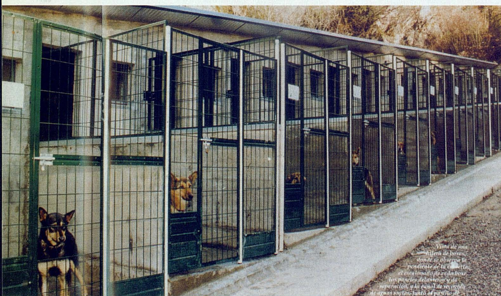
Vista de una hilera de boxes, en el Centre Caní Andorra, donde se observa la pendiente de la cubierta, el escalonado de cada boxe, los paneles delanteros y de separación y el canal de recogida de aguas sucias junto al pasillo de servicio.
