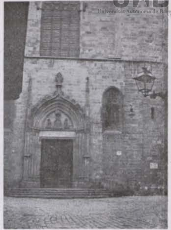
Façana de l'Església de Sant Just, a Barcelona, en una capella de la qual es venera Sant Jordi
