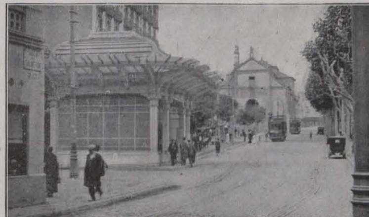
Estació dels Josepets del tren subterrani (Metropolità)
