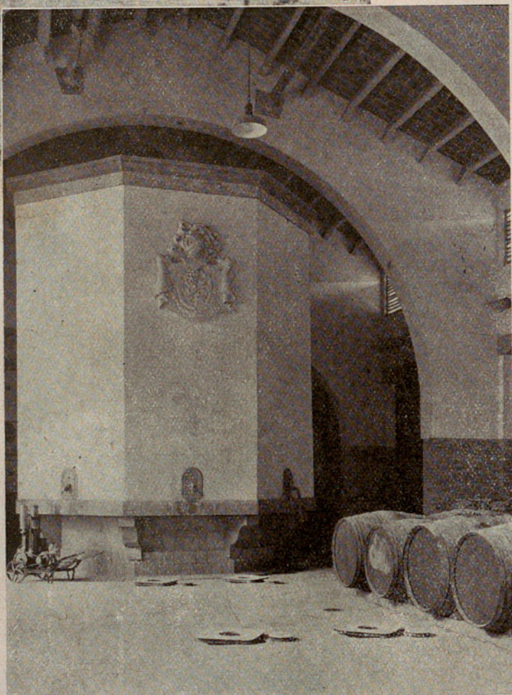
Depósito de 116.000 litros de capacidad, destinado a la mezcla de vinos
