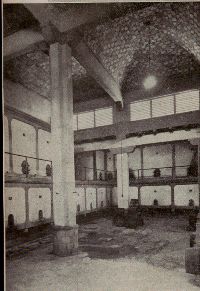
Depósito de 116.000 litros de capacidad, destinado a la mezcla de vinos
