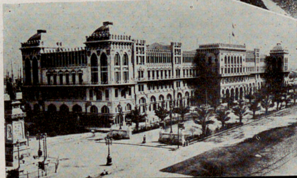
El Hotel del Universo, una de las maravillas de la Exposición de 1888. Fue levantado en el Paseo de Colón, junto a la plaza de Antonio López, en poco más de veinte días
