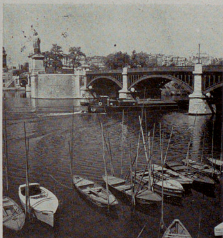
El puente de Grenelle, construido en hierro, ofrece en su centro una reproducción a escala normal de la famosa estatua neoyorquina de la Libertad
