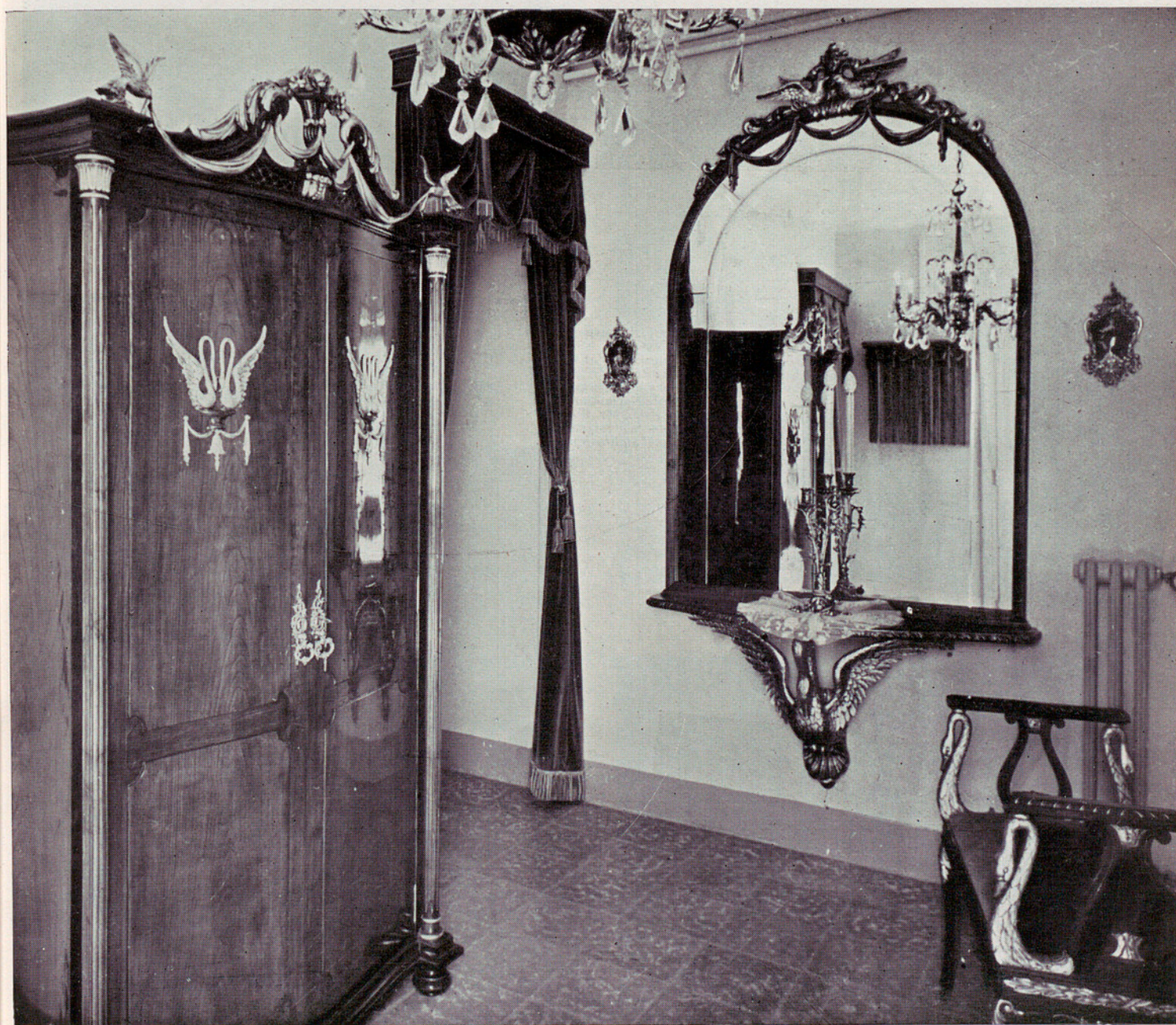
Instalaciones de la residencia de los señores de Gimeno.
