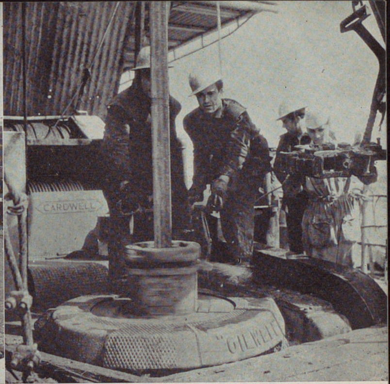
Obreros petroleros trabajan alrededor de la mesa rotativa de un "derrick" levantado en la zona de Comiso. La excavación, positiva, perforó la roca impermeable a dos mil metros de profundidad.
