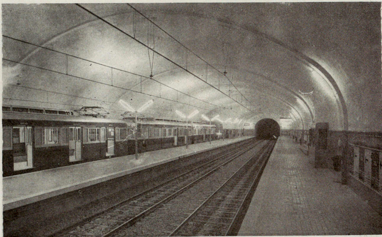
Estación Villapiscina. A la izquierda parte del nuevo material puesto en servicio por F. C. Metropolitano de Barcelona
