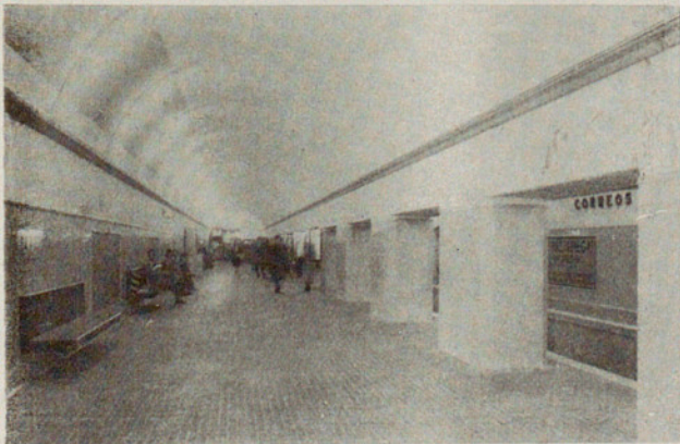
Estación CORREOS completamente reformada.
