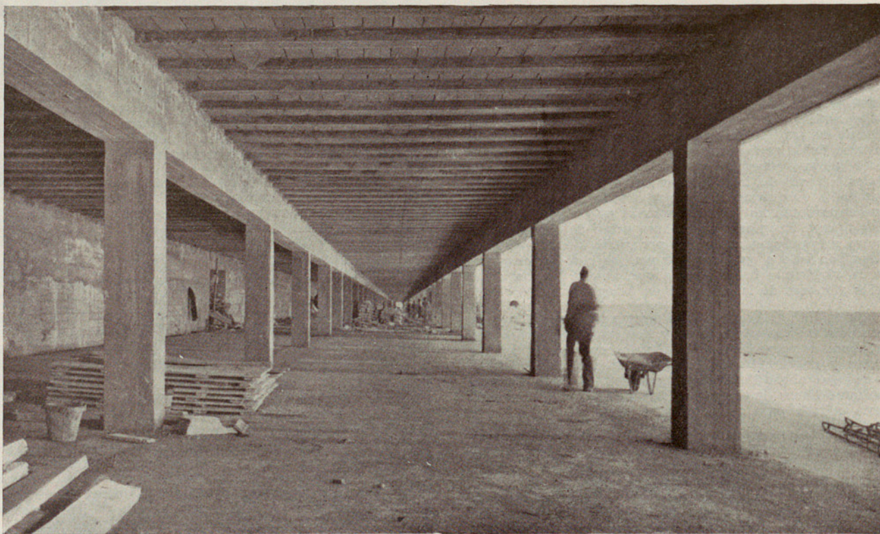
El Paseo Marítimo de Barcelona está levantado, a toda prueba, sobre este armazón de cemento donde se alojarán los servicios de los baños públicos y merenderos de la playa
