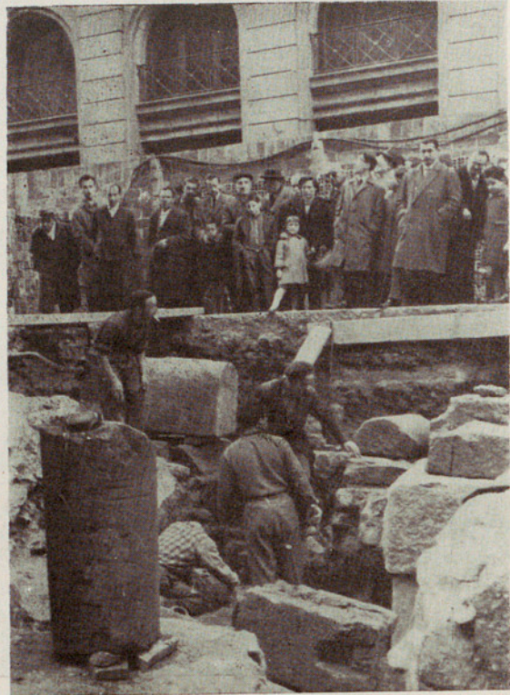
Las excavaciones que se practican en el trecho de muralla romana correspondiente a la calle de Tapinería, atraen nutrido concurso de público, símbolo de la curiosidad e interés con que las sigue la ciudad entera. (Fotos Pérez de Rozas).
