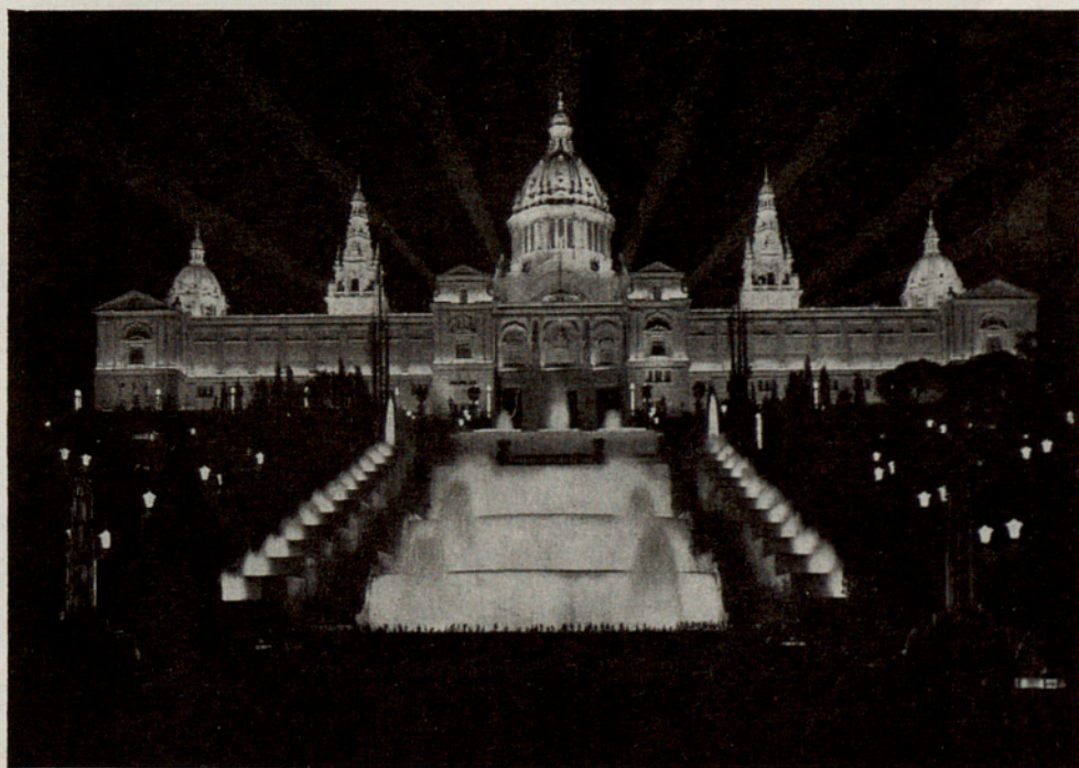
Conjunto luminoso de Montjuich.
