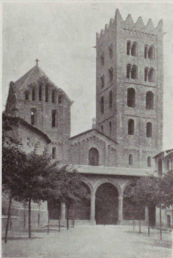
Fachada y claustro del monasterio de Ripoll.
