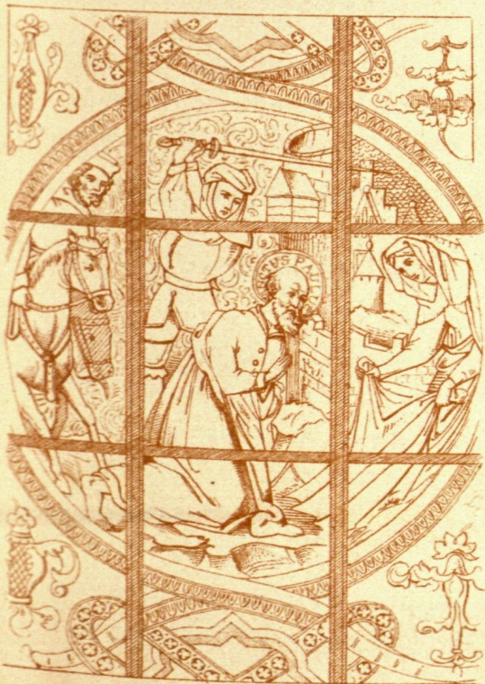
Fig. 923. - Martirio de San Pablo Apóstol, vidriera en colores de la iglesia del Burgo (Burgkirche)
