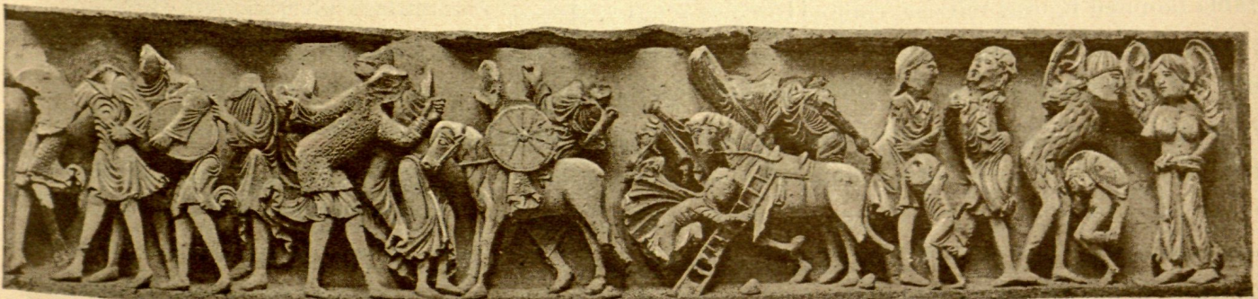
Fig. 866. - Bajo relieve de la parte inferior del tímpano de la iglesia románica de Vezelay
