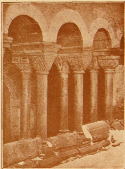
Fig. 1019 - COLUMNAS DEL CLAUSTRO DE SANTA MARÍA DEL ESTANY (CATALUÑA)
