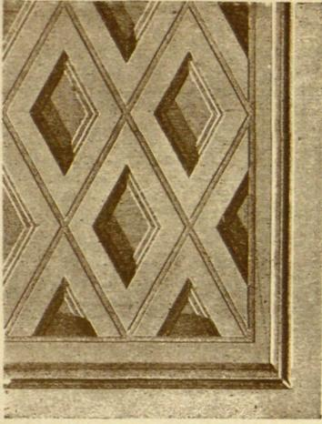
Fig. 369. - ARTESONADO DE LOS PÓRTICOS LATERALES DEL TEMPLO DE BASSÆ, SEGUN BLUET.
