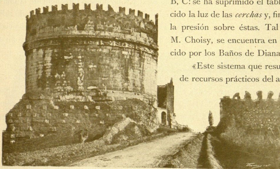
Fig. 492. – TUMBA DE CECILIA METELA EN ROMA (Opus emblecton en el basamento, viéndose las cabezas de los perpaños, diatonos de Vitrubio)
