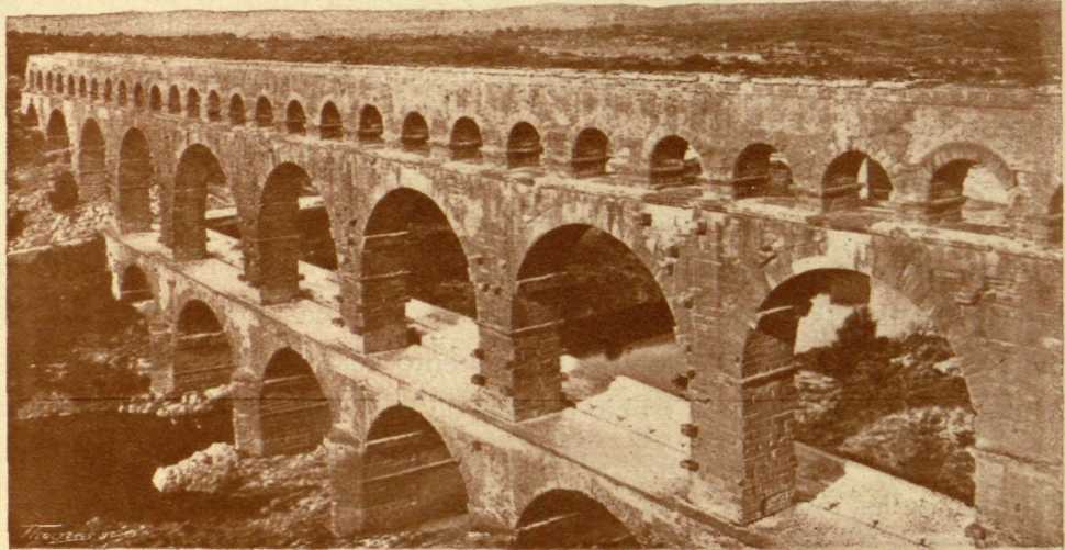
Fig. 488. — ACUEDUCTO DE GARD (situado á 27 kilómetros de Nimes)
