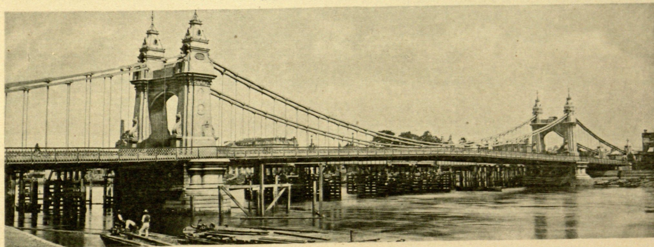
Puente de Hammersmith
